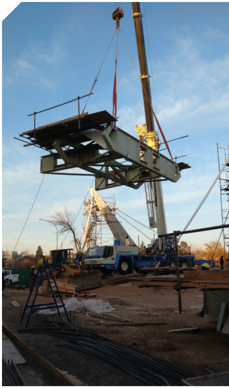
Foto 2 Montaje de dovelas.
