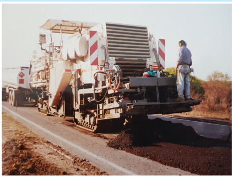
Figura 17. Reciclado in situ con emulsión Ruta 81, Formosa.
