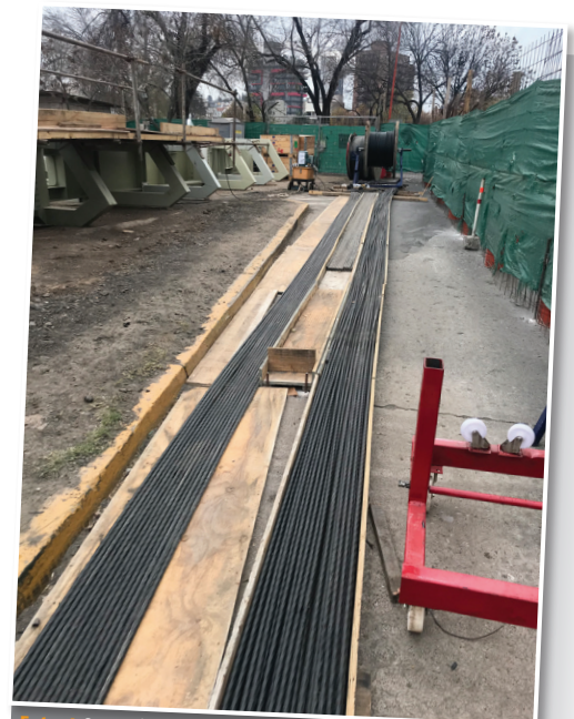
Foto 4 Cama de corte de torones.
