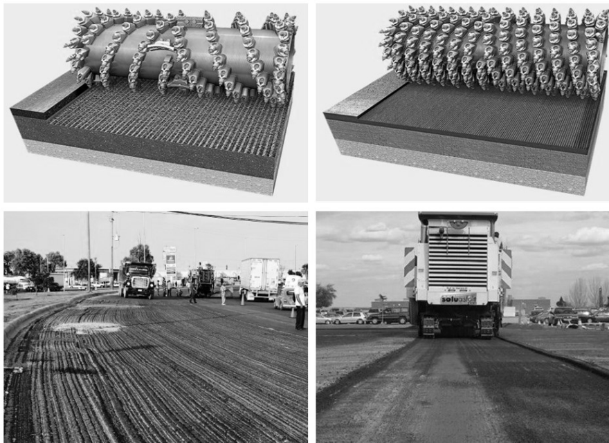
Figura 35.3. Fresado Estándar y las diferentes texturas obtenibles
