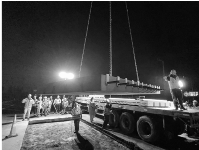
Figura 48.3. Losas de la técnica CAPH desarrolladas por la Universidad Católica de Chile
