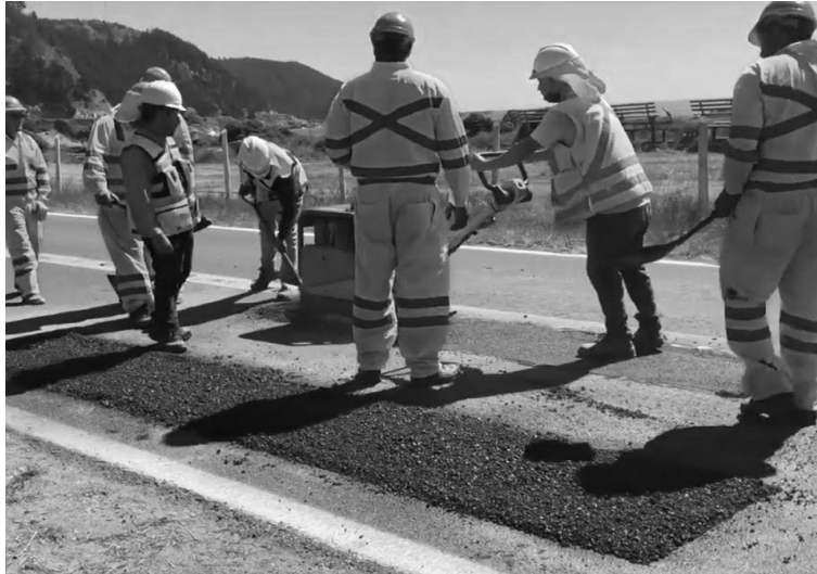
Figura 43.5. Llenado de bache y compactación a tope
