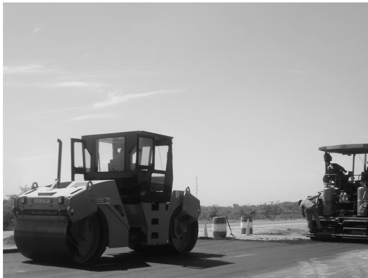
Figura 31.3. Ingreso de rodillo liso inmediatamente después de la terminadora
