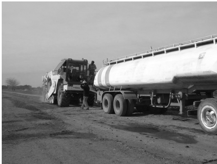
Figura 34.4. Reutilización de un pavimento mediante recicladora
