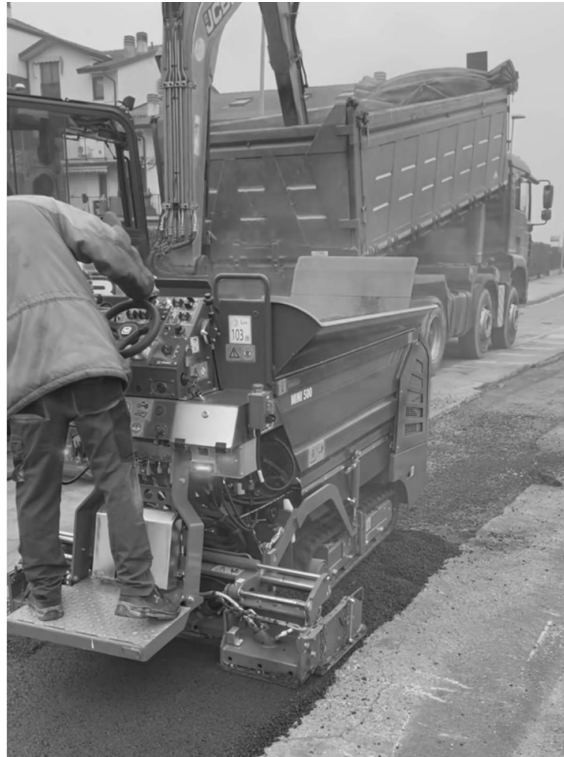
Figura 43.2. Empleo de terminadora de dimensiones reducidas en bacheos
