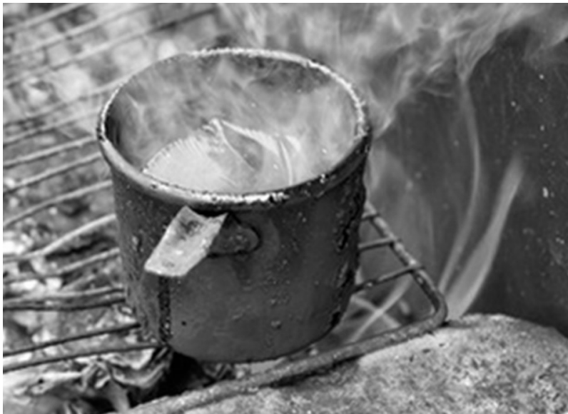
Figura 44.1. Calentamiento directo a la llama de un sellador asfáltico
