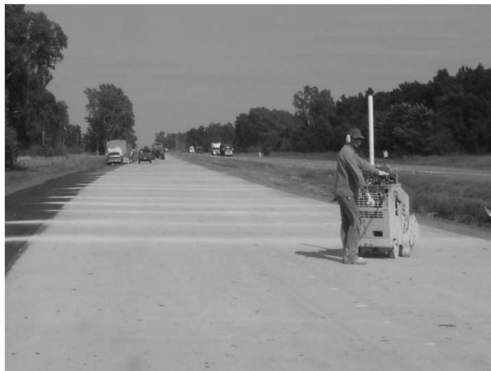
Figura 26.4. Aserrado de juntas de contracción
