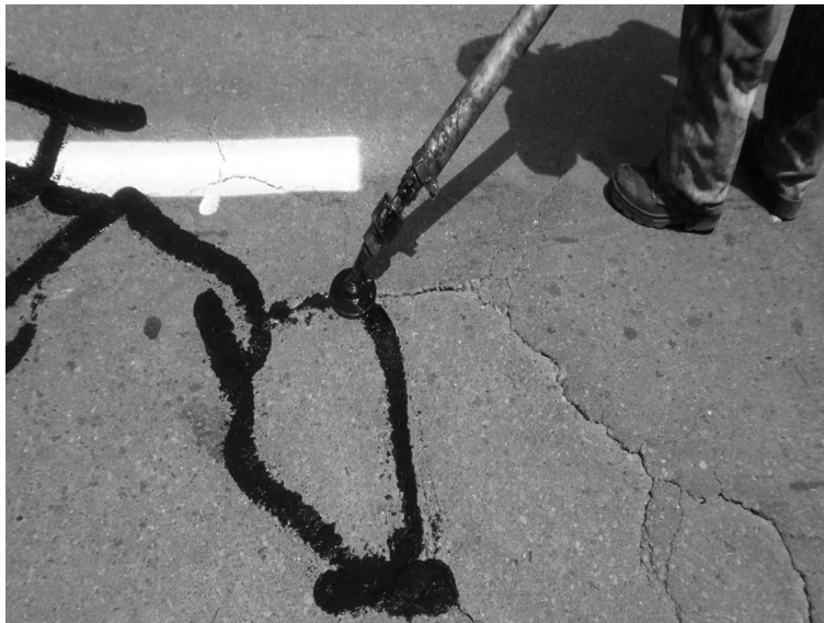
Figura 44.4. Lanza y distribución del sellador asfáltico
