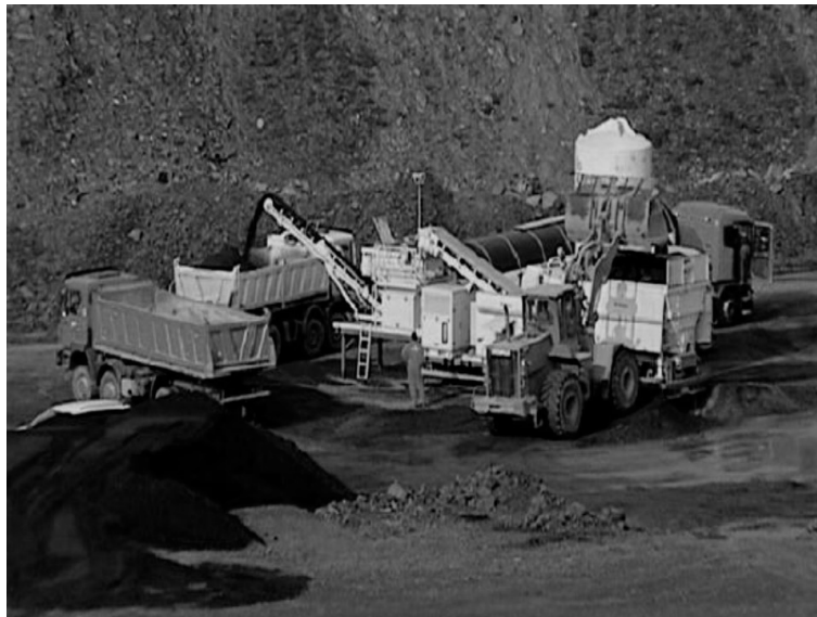
Figura 38.3. Planta asfáltica en frío produciendo con aporte de RAP
