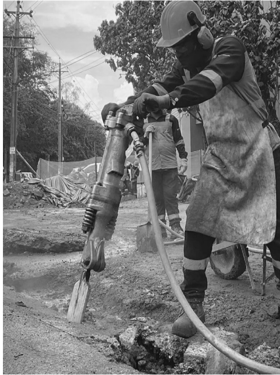
Figura 41.6. Uso de cincel en demolición de losa
