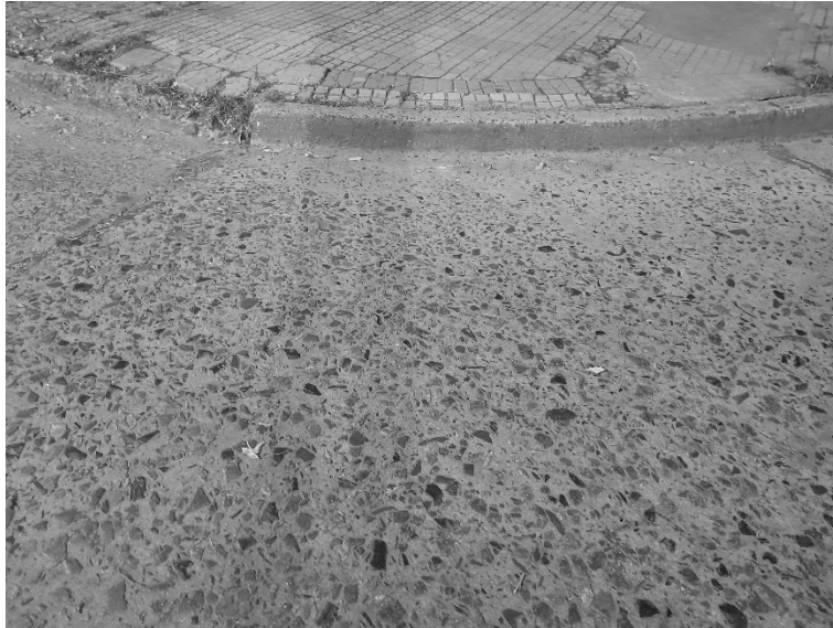
Figura 26.1 Pavimento antiguo que permite observar sus agregados de tamaño máximo elevado
