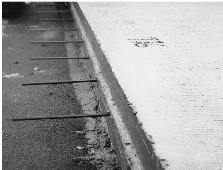
Figura 26.6. Barras de unión en una junta longitudinal
