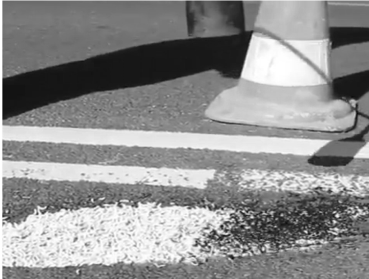
igura 43.8. Sistema Glass Mat Thermoplastic para bacheo
