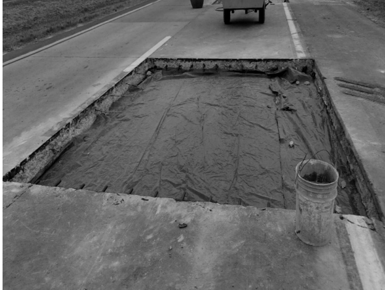
Figura 47.3. Solución no adherida mediante manta de polietileno
