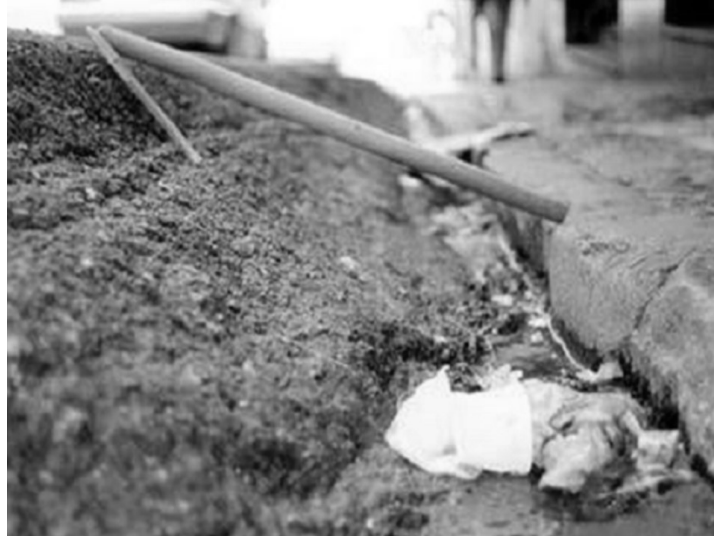
Figura 35.4. Recrecido de un pavimento asfáltico urbano
