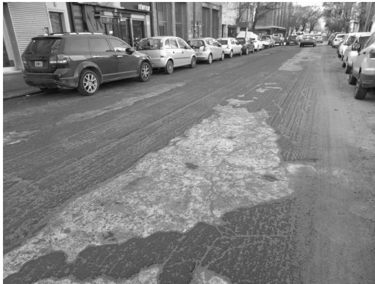
Figura 35.6. Fenómeno de descascamiento por fresado
