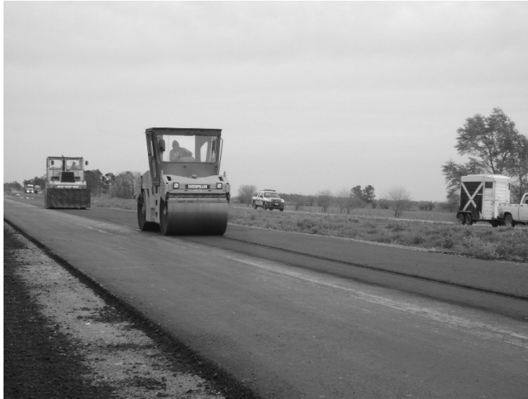
Figura 31.4. Primera compactación con el rodillo liso e ingreso del rodillo neumático
