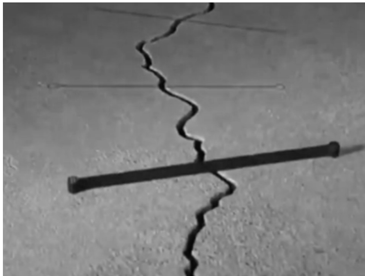
Figura 46.3. Barras con extremos para cosido de fisuras
