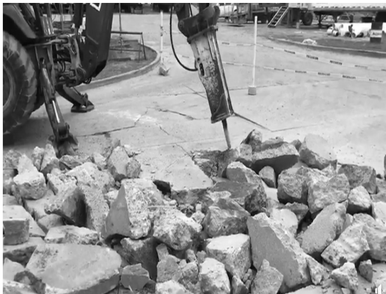
Figura 41.2. Demolición de losa con martillo neumático con punta
