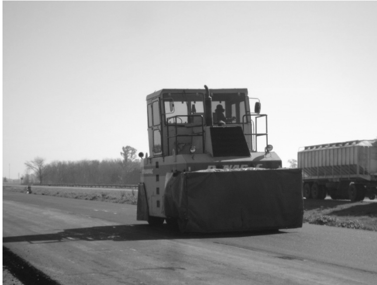
Figura 31.1. Protección con lona de un rodillo neumático
