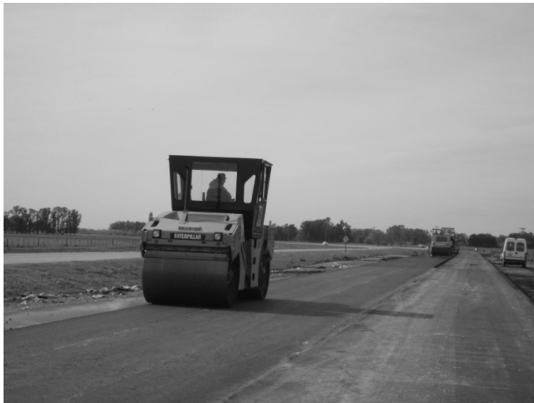
Figura 31.5. Al fondo rodillo neumático compactando e ingreso final del rodillo liso
