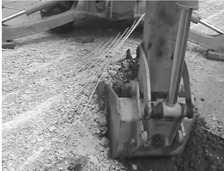
Figura 40.7. Retiro de armadura en pavimento luego de rubblizing ( resonantmachines.com/es_ES/ )
