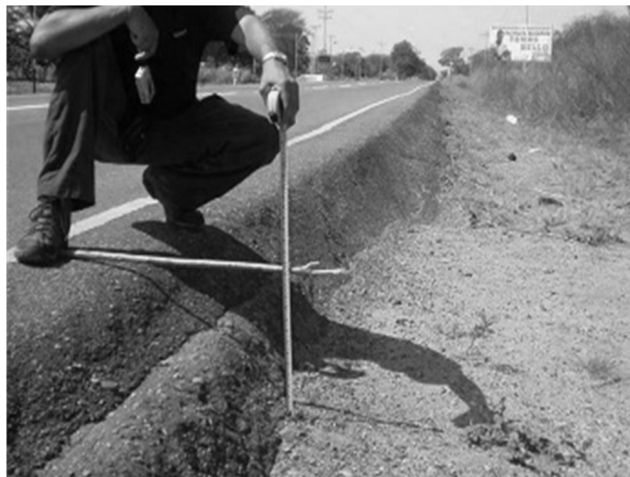
Figura 35.5. Recrecido de un pavimento asfáltico rural
