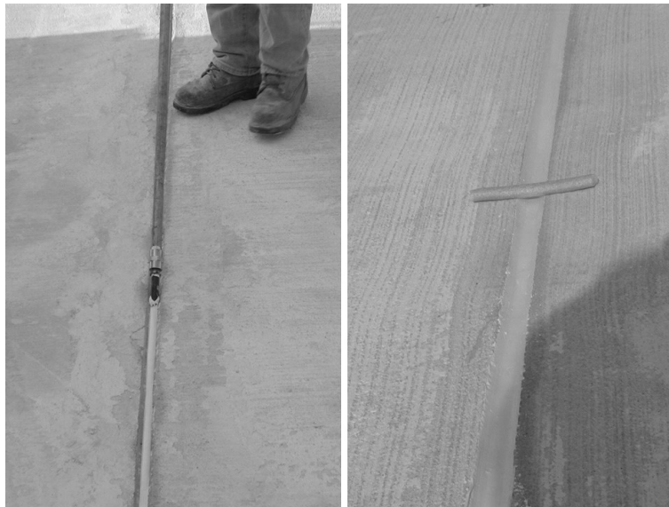
Figura 44.9. Tomado de junta en pavimento de hormigón con sellador siliconado
