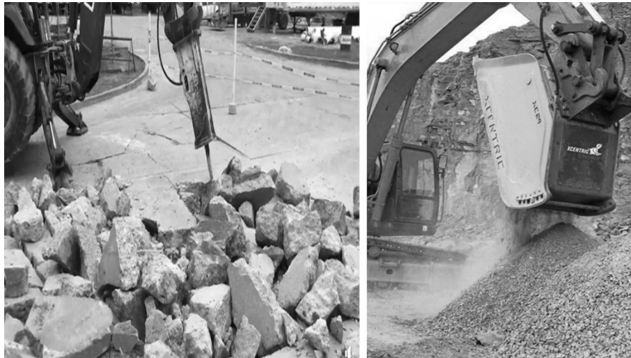
Figura 40.4. Uso in situ de martillo hidráulico (izq.) más trituradora portátil (der.) ( https://xcentricripper.com/es/ )
