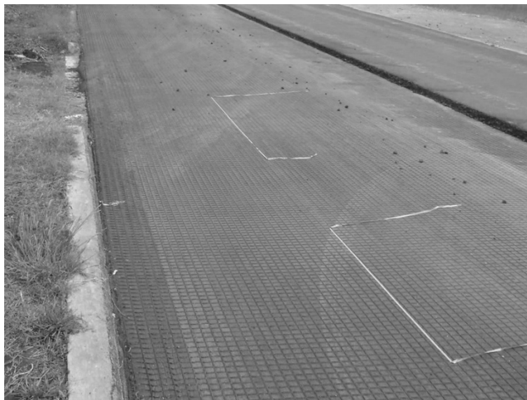
Figura 34.3. Geosintético como SAMI en una rehabilitación
