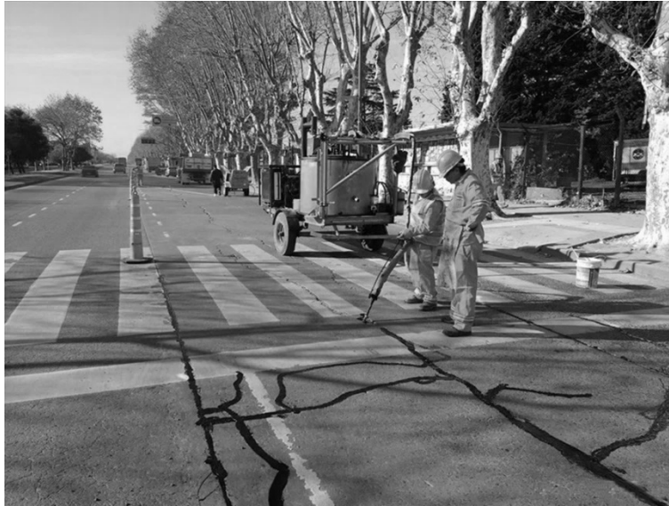
Figura 44.3. Fusora para sellador asfáltico
