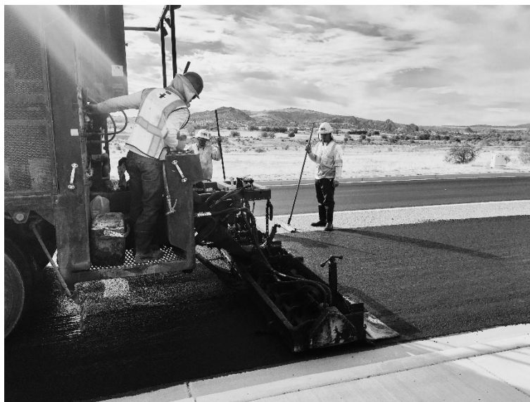
Figura 28.1. Microaglomerado en frío sobre pavimento de hormigón ( https://www.slurry.org/ )
