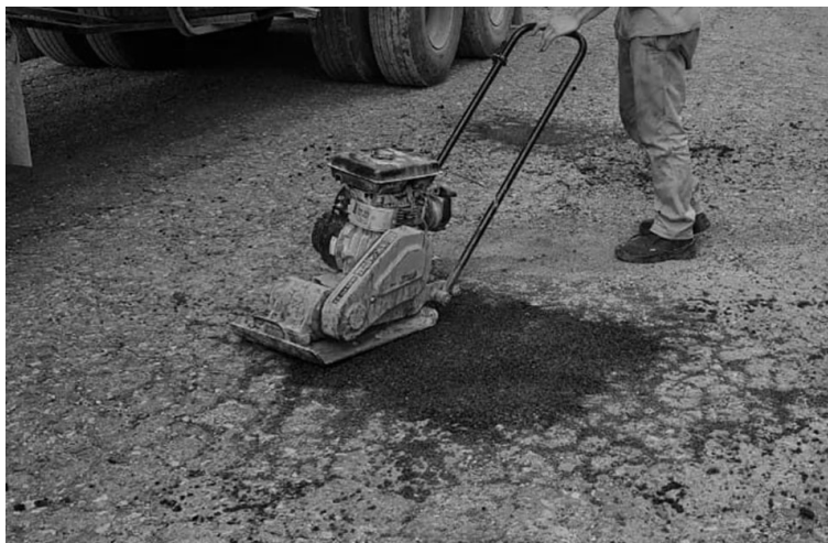
Figura 42.1. Solución inadecuada de un bache superficial
