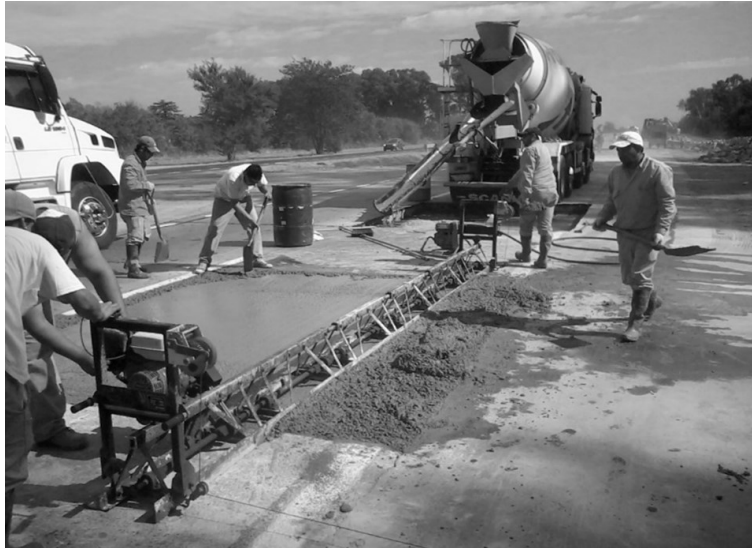
Figura 47.7. Reglado superficial de la losa reconstruida
