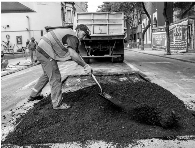
Figura 43.1. Llenado de un bache de manera manual
