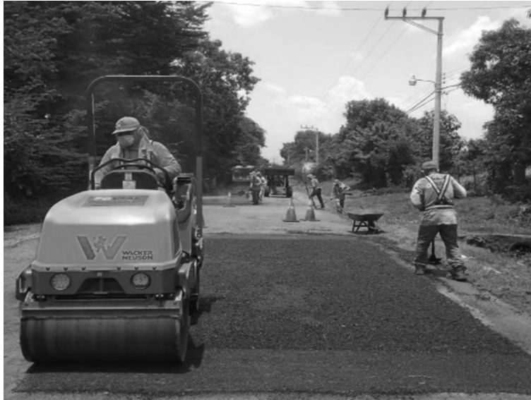
Figura 43.3. Compactación en un bache con rodillo autopropulsado
