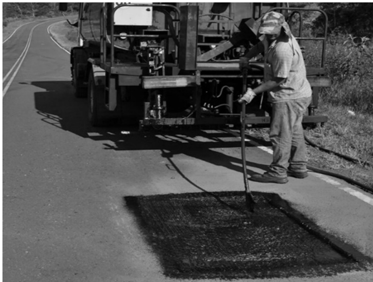
Figura 42.5. Buena aplicación de un riego asfáltico en un bache
