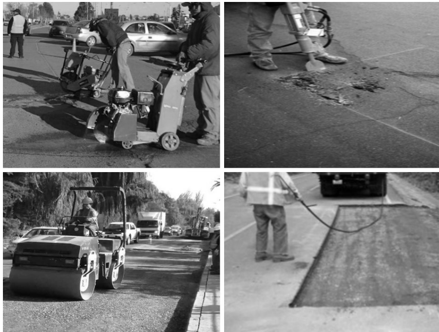
Figura 42.2. Recorte y reconfiguración de base en bache, previo al riego de liga
