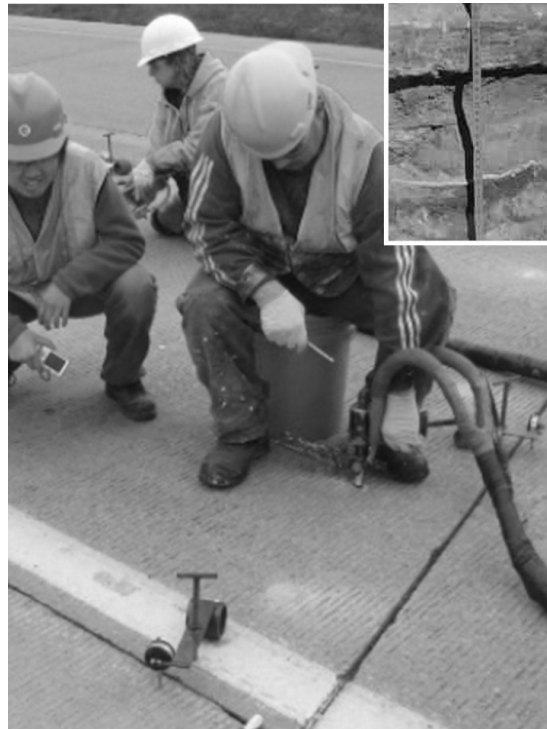
Figura 50.4. Imagen de la inyección de losa con lechada de cemento en obra
