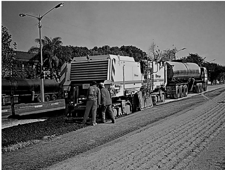
Figura 39.1. Recicladora montada en orugas ( www.wirtgen-group.com/es-ar/ )
