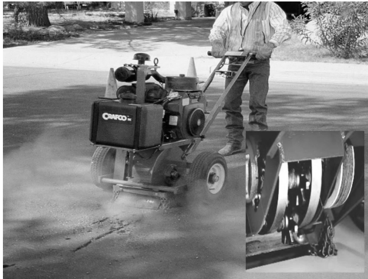
Figura 44.7. Ruteadora en un pavimento asfáltico
