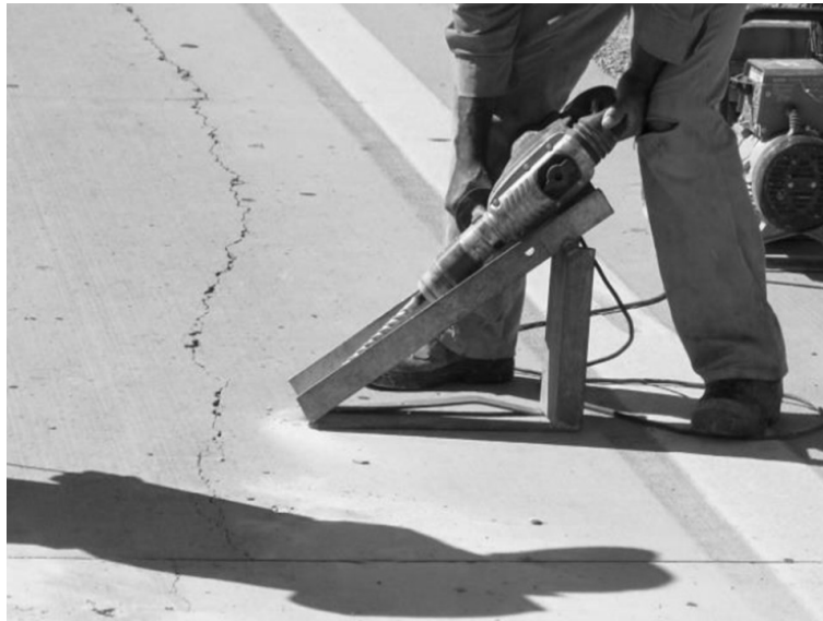
Figura 46.1. Perforado para cosido cruzado (ICPA, 2016)
