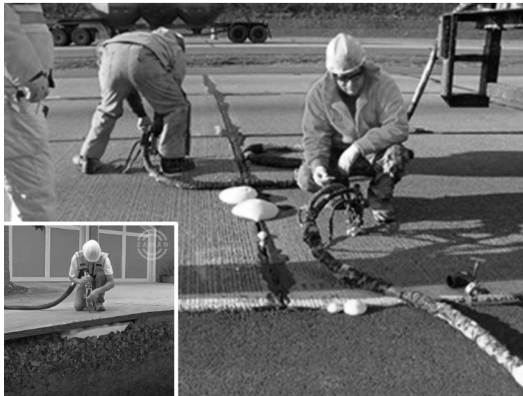
Figura 50.5. Imagen de la inyección de losa con espuma de poliuretano rígida en obra
