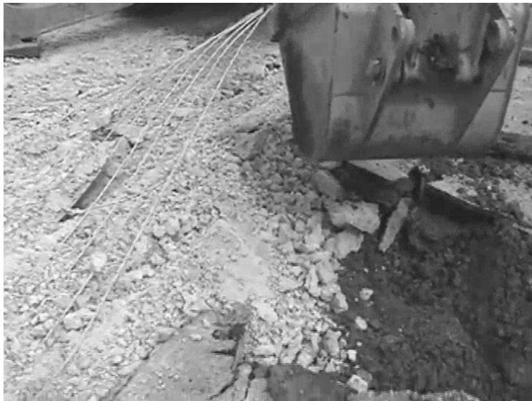
26.2 Retiro de armadura en pavimento antiguo demolido ( https://resonantmachines.com/es_ES/rubblizing/ )
