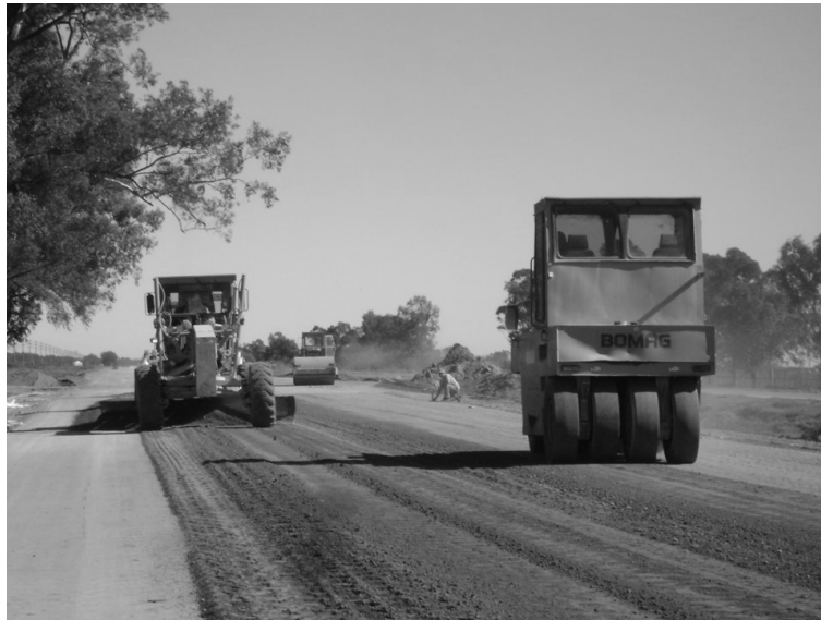
Figura 30.4. Rodillo neumático autopulsado, combinado con rodillo liso
