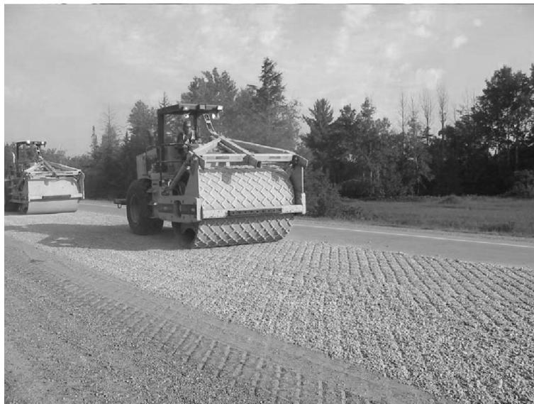
Figura 40.2. Uso de z-grid roller y rodillo liso (Thompson, 2006)
