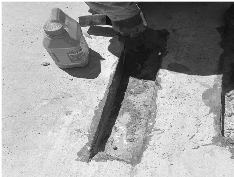
Figura 45.5. Receptáculo del pasador con material de adherencia
