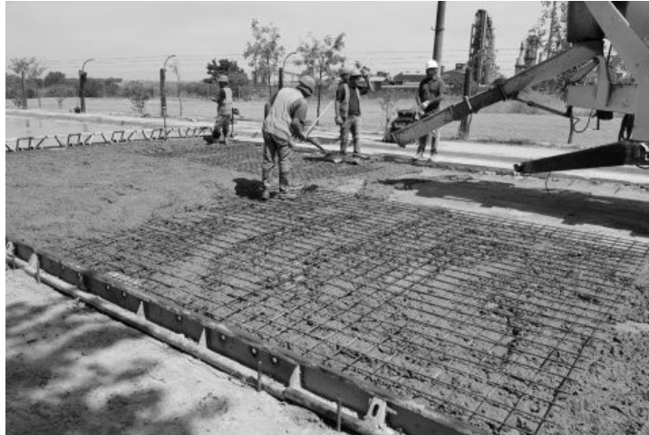
Figura 26.8. Pavimento de hormigón armado (Municipalidad de Olavarría, 2018)
