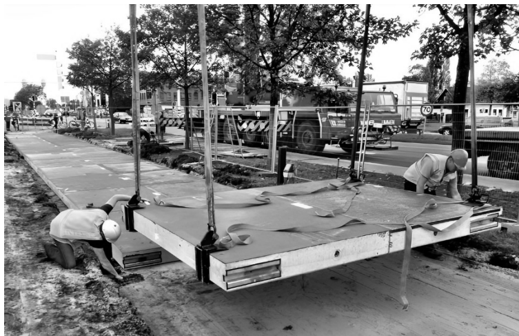
Figura 48.2. Losa pretensada de hormigón para pavimento (Snyder, 2021)
