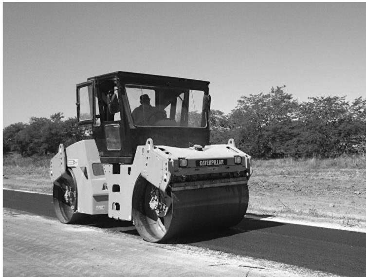
Figura 31.2. Empleo de agua para evitar adherencia en un rodillo liso
