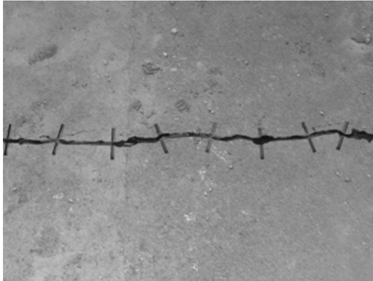
Figura 46.2. Cajas para barras horizontales no paralelas entre sí
