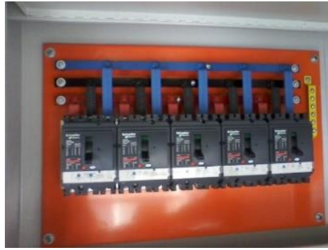
Imagen 124 - Ejemplo de barras en tablero
