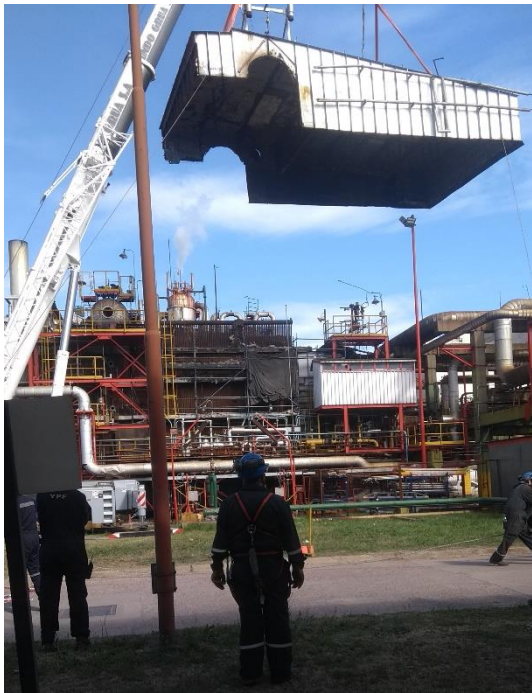
Fig. 2 - Desmontaje de techo de cierre.
