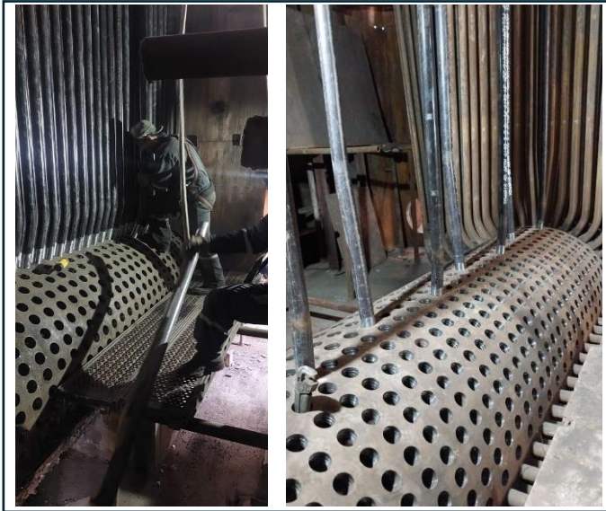
Fig. 7a - Montaje de tubos de banco de generación.
