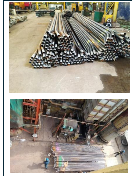
Fig. 7b - Tubos acopiados al pie de la caldera para facilitar su manipuleo y montaje.
