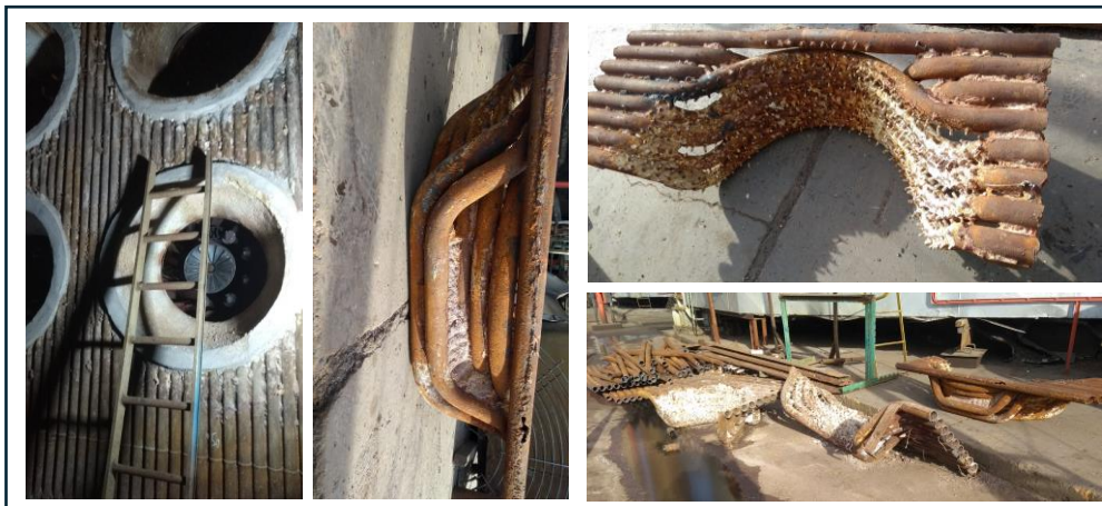
Fig. 8b - Pared de quemadores antes del desguace, nidos de quemadores con los anclajes del refractarios expuestos.
