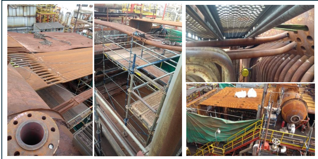
Fig. 8a - Reemplazo de tubos de techo, inserción en domos, vista alejada del conjunto.
