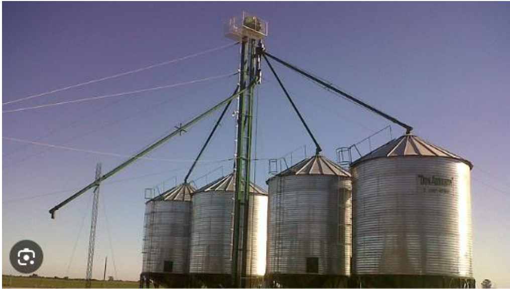
Figura 15: planta de silos con noria central
