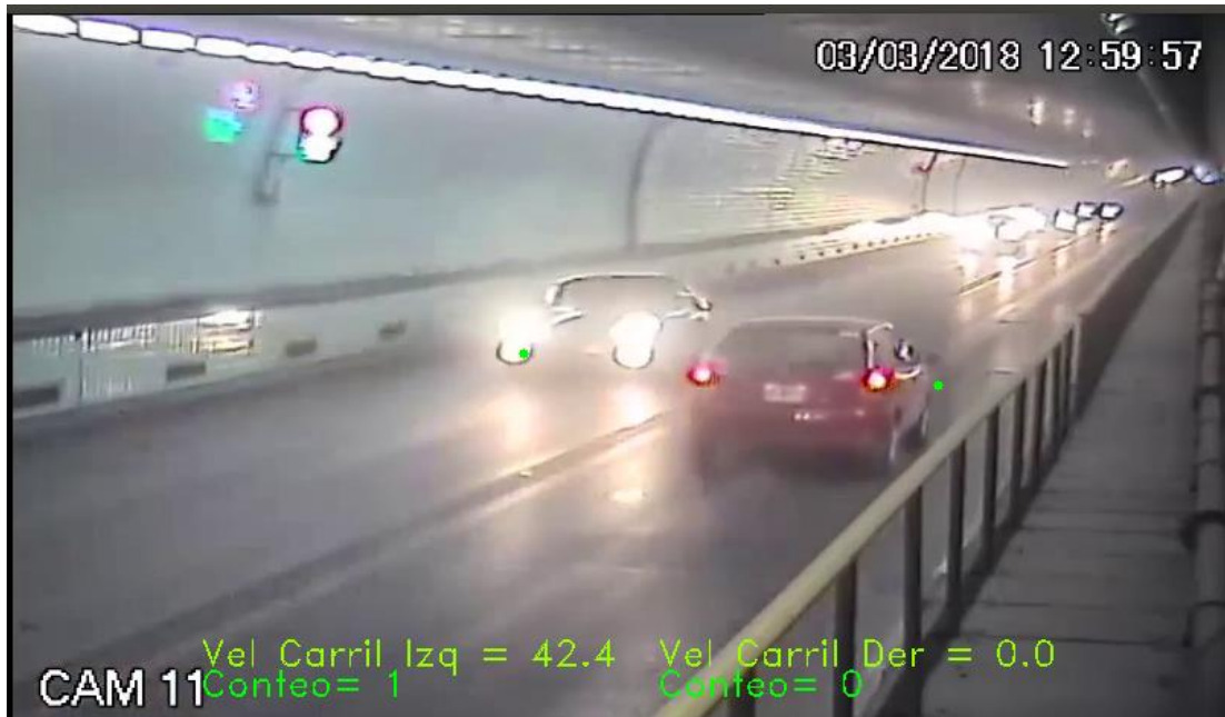
Figura 38 - Imagen procesando el tráfico en el Túnel.
