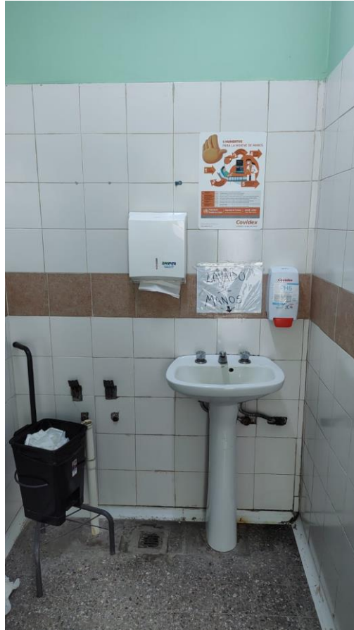
Fotografías del interior de uno de los baños.
