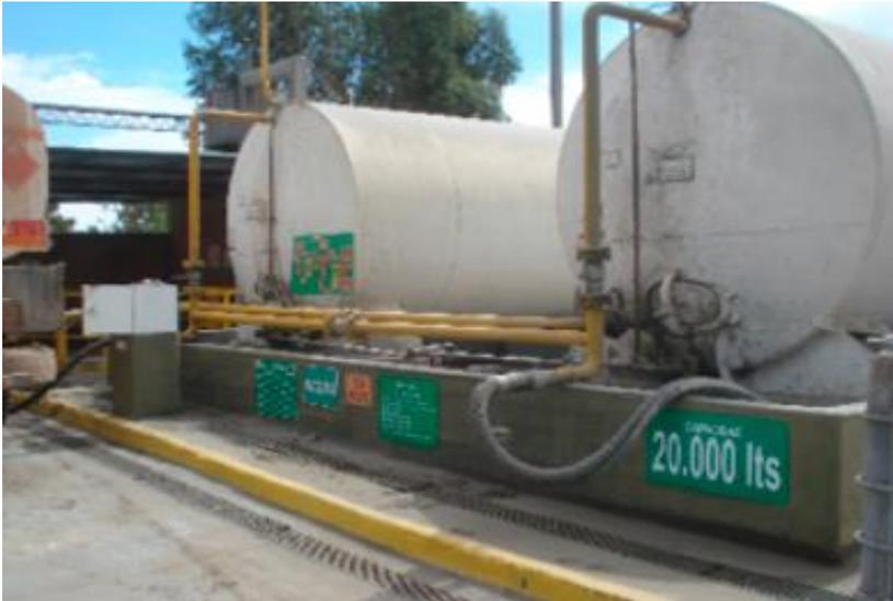
*Foto 3 Tanques de almacenamiento del residuo líquido en planta de cemento (2019).*
