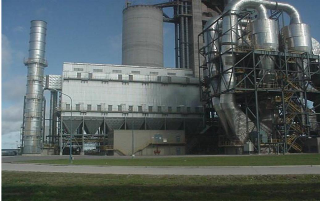
*Foto 13 Filtro de mangas de salida de gases del horno en planta de cemento (2019).*
