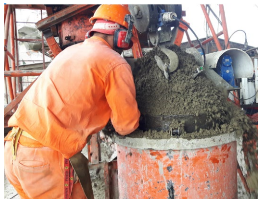
Figura 7. Llenado manual de tubos.
