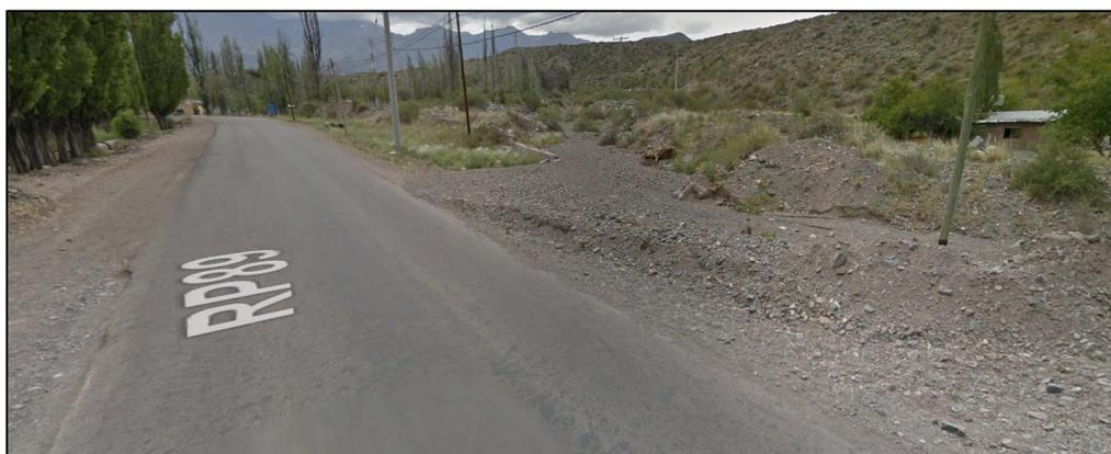
*Figura 15: Intersección de cauce aluvional seco con la RPN°89. Se observa que actualmente no se cuenta con ninguna obra de arte en dicho punto. Fuente: software Google Earth (octubre 2021).*
