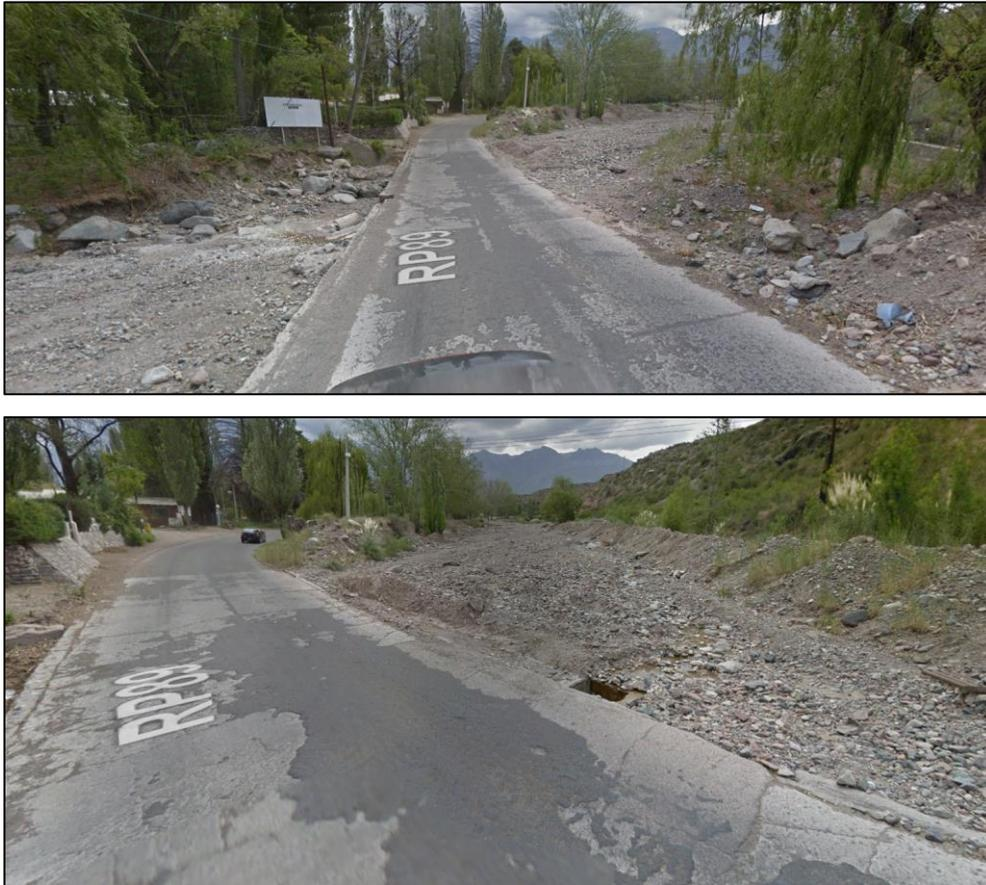
*Figura 16: Badén existente en el cruce de la RPN°89 y el A° El Salto. El mismo se encuentra bastante deteriorado, y durante las crecidas aluvionales se interrumpe el paso por la carretera. Fuente: software Google Earth (octubre 2021).*
