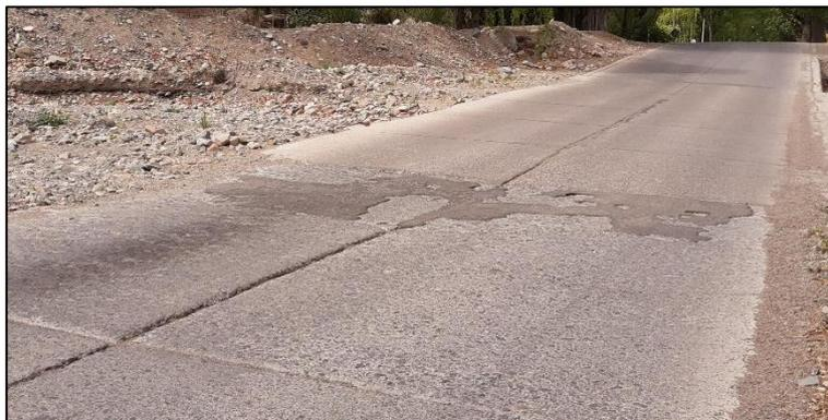
Figura 36: Técnica de mantenimiento incorrecta aplicada en pavimento rígido. Fuente: Elaboración propia.
