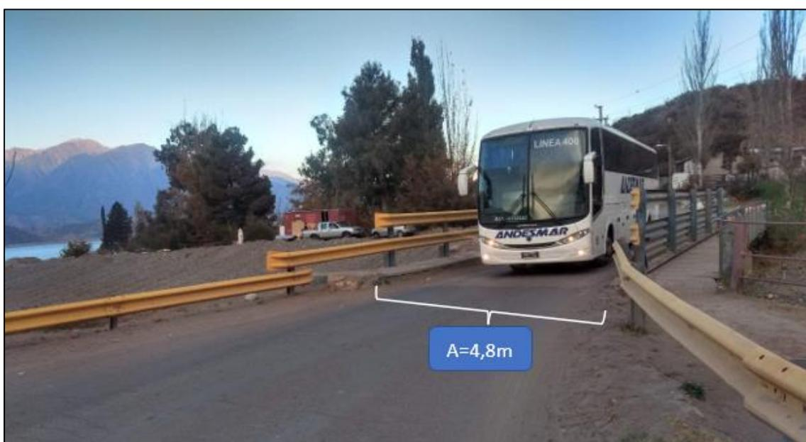
Figura 119: Escaso ancho de calzada, de único sentido de circulación. Fuente: Imagen tomada in-situ, elaboración propia.
