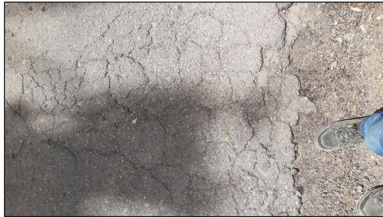
*Figura 25: Piel de cocodrilo y fisuras de borde en la capa de rodamiento. Fuente: Elaboración propia.*
