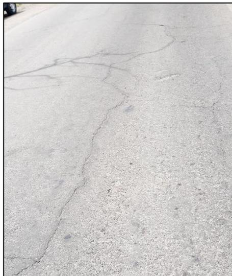
*Figura 30: Fisura longitudinal sobre pavimento existente. Fuente: Elaboración propia.*
