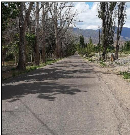
*Figura 27: Falta total de demarcación horizontal sobre la calzada. Fuente: Elaboración propia.*
