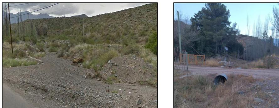
Figura 151: cauce natural desviado por banquina lateral hacia la ubicación de la alcantarilla Alc\_04. Fuente: elaboración propia.
