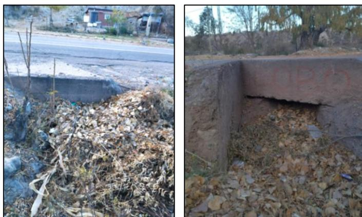
Figura 139: Alcantarilla en el lugar, aguas abajo y aguas arriba. Fuente: elaboración propia.
