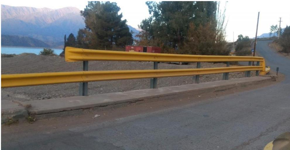
Figura 129: protección con barreras metálicas actual del puente sobre el Río Blanco. Fuente: Imagen tomada in-situ, elaboración propia.
