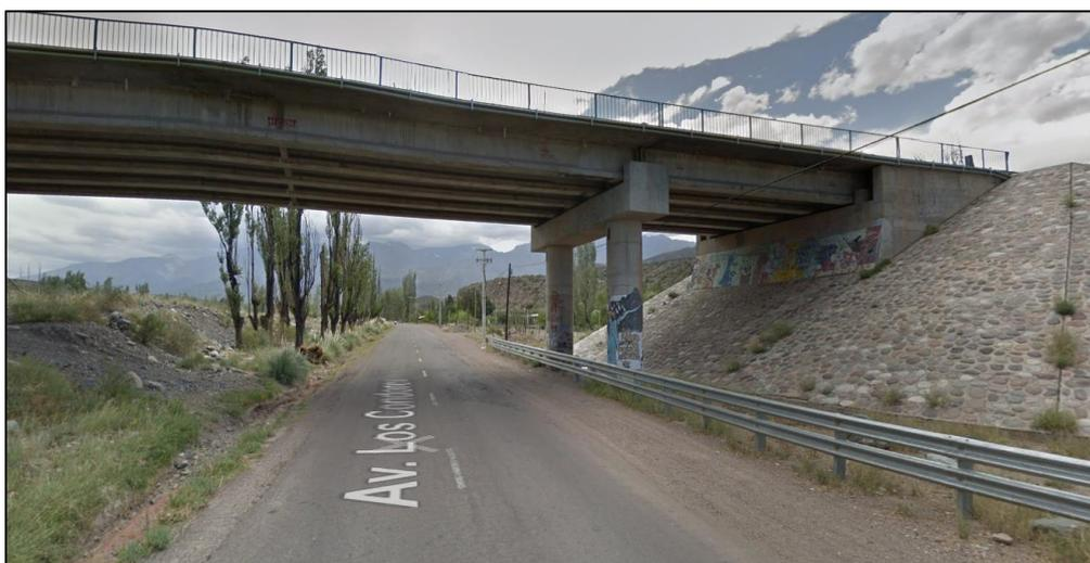
Figura 13: limitaciones espaciales por las pilas del puente de RN N°7 por sobre la RPN°89. En caso de plantear un ensanchamiento de carriles y banquetas, el eje del camino se deberá desplazar hacia el sur. Fuente: software Google Earth (octubre 2021).
