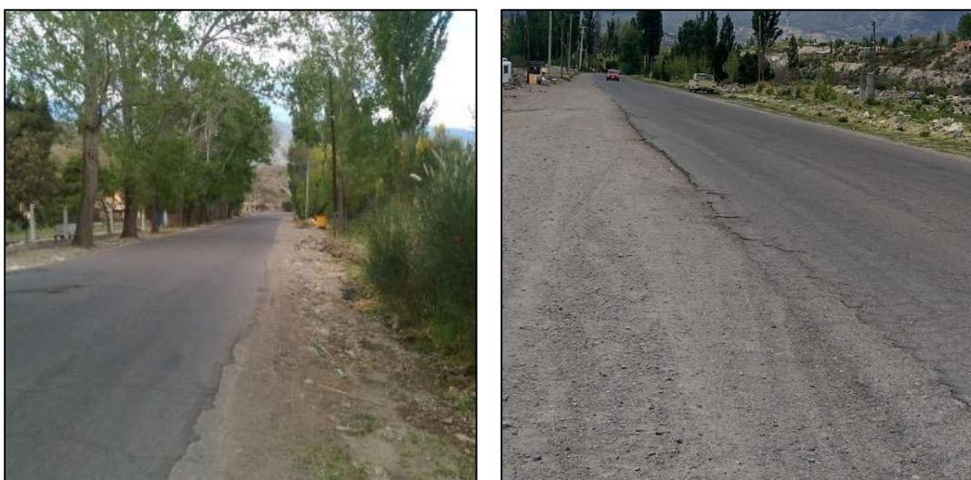
Figura 37: Banquinas inexistentes y en mal estado. Fuente: Elaboración propia.
