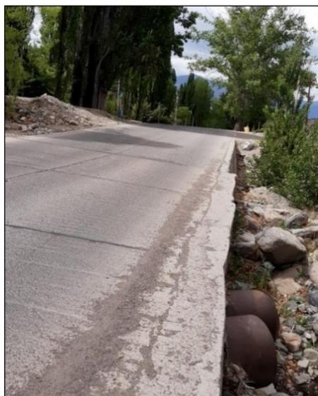
*Figura 126: Condiciones de socavación actuales. Fuente: Imagen tomada in-situ, elaboración propia.*
