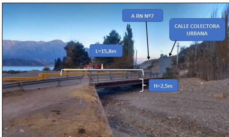
Figura 118: Estudio de dimensiones geométricas puente actual. Fuente: Imagen tomada in-situ, elaboración propia.
