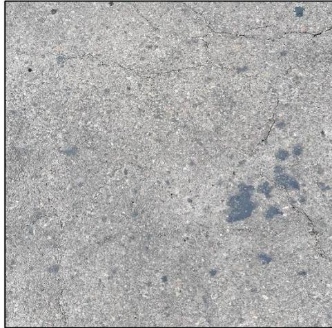
*Figura 33: Desgaste de capa de rodadura. Fuente: Elaboración propia.*
