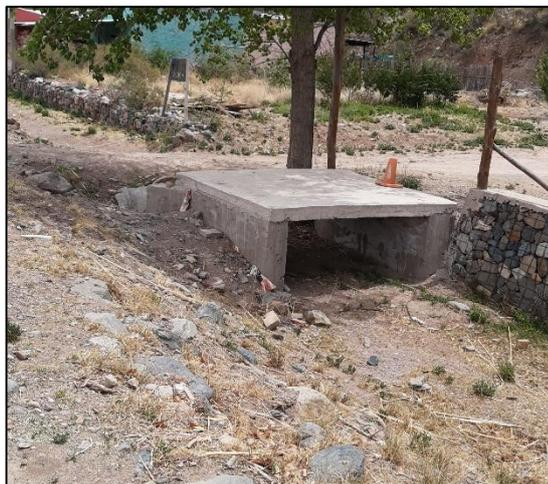
Figura 24: Detrás del puente de hormigón, en desuso, se encuentra un bloqueo a la sección de escurrimiento del préstamo lateral a la RP89. Fuente: Elaboración propia.
