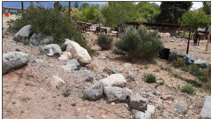
Figura 23: Pérdida de la sección de escurrimiento del préstamo en margen norte. Fuente: Elaboración propia.
