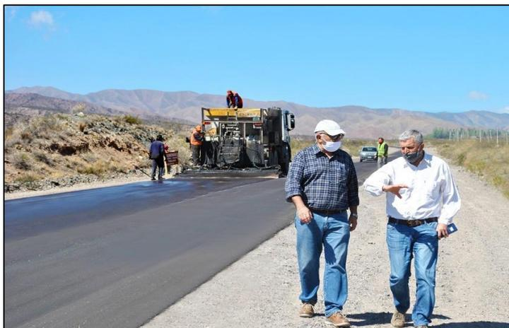
*Figura 3: obras de repavimentación de la RP89 entre el acceso a El Salto y la localidad de Las Vegas. Fuente: página web de la Dirección Provincial de Vialidad (2020).*
