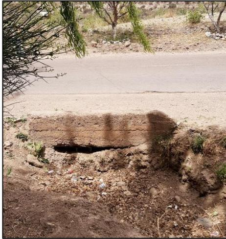
Figura 22: alcantarilla prácticamente bloqueada. Fuente: Elaboración propia.
