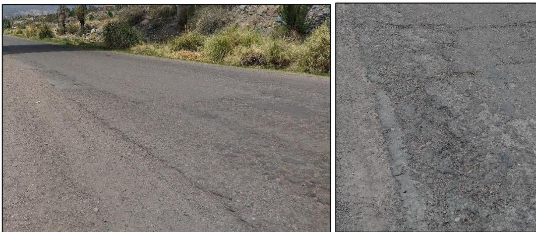
Figura 32: Pérdida del agregado en capa de rodadura. Fuente: Elaboración propia.
