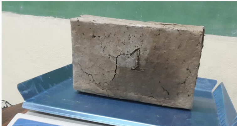
Figura 3. Adobe con fisuras Fuente: elaboración propia
