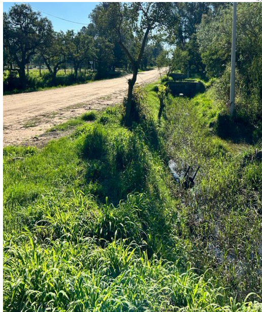
Canal paralelo a Santa Rosa - Intersecc. Callejón Pintos
