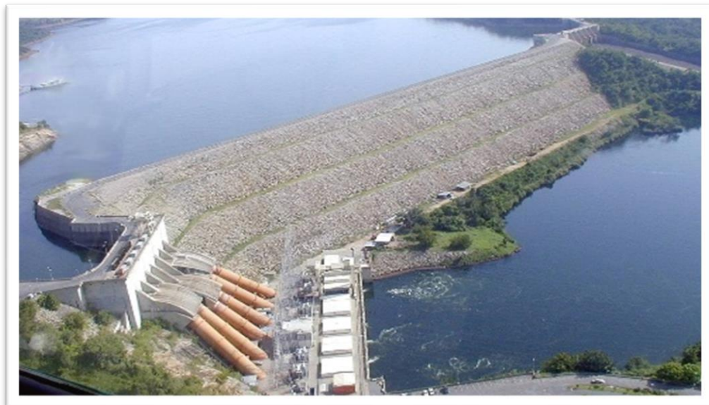
Figura n°13: Central Hidroeléctrica de Embalse.
