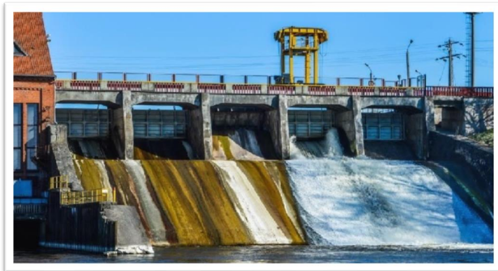
Figura n°12: Central hidroeléctrica por derivación.
