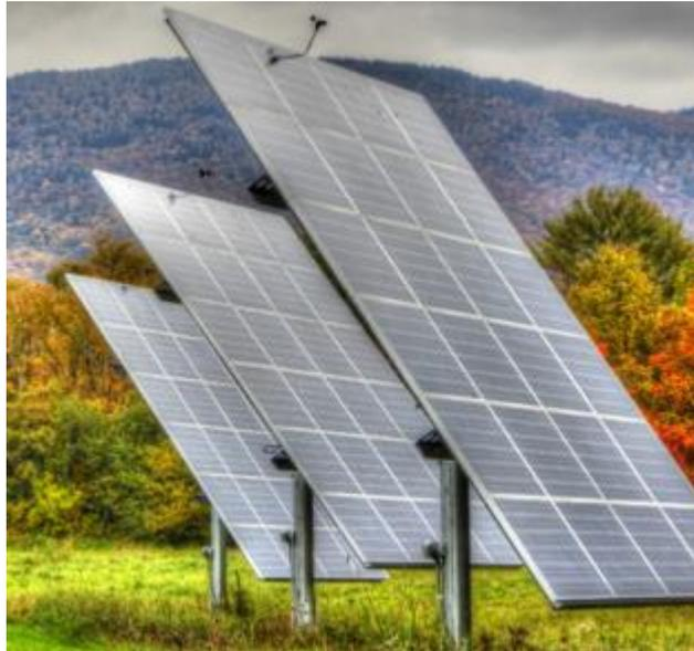
Figura 14. Imagen paneles solares con estructura seguidora de sol
