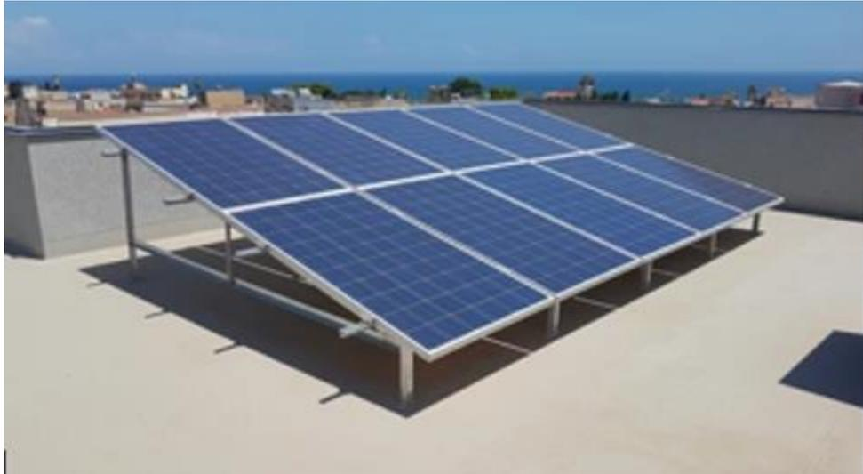
Figura 12. Imagen de paneles solares con soporte a 30° sobre techo plano
