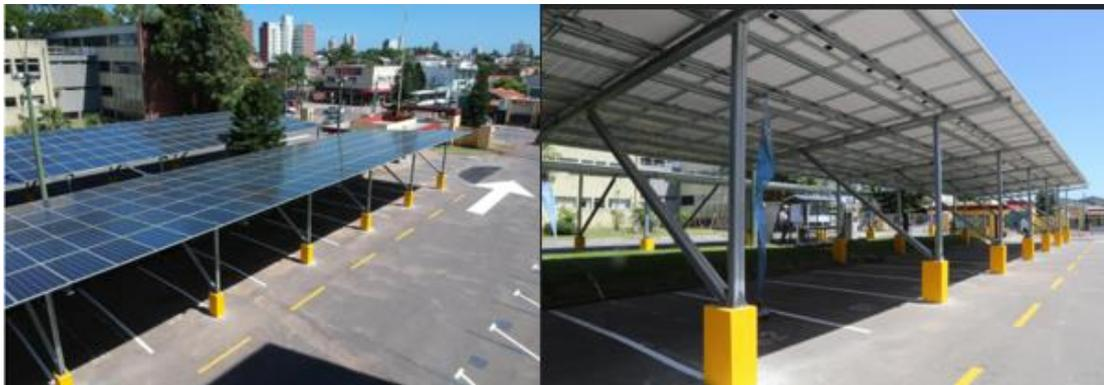
Figura 13. Imagen de p. solares sobre estructura para estacionamientos<sup>7</sup>
