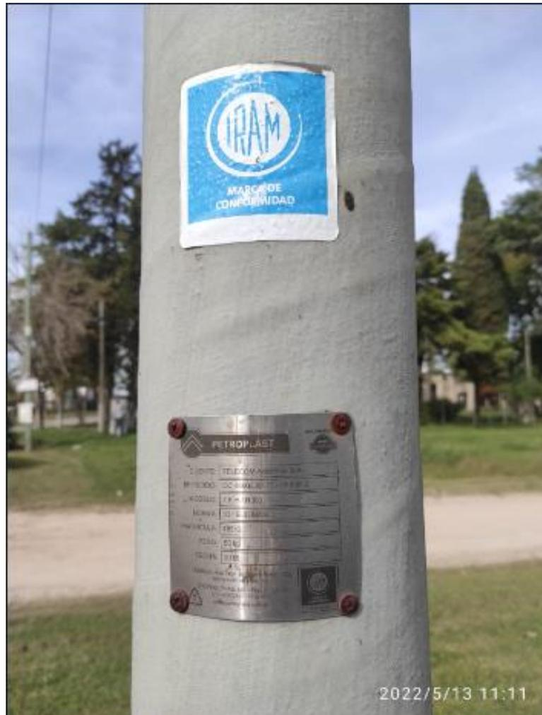
*Imagen: Columna de PRFV para poste de tendido telefónico. Fuente: elaboración propia.*
