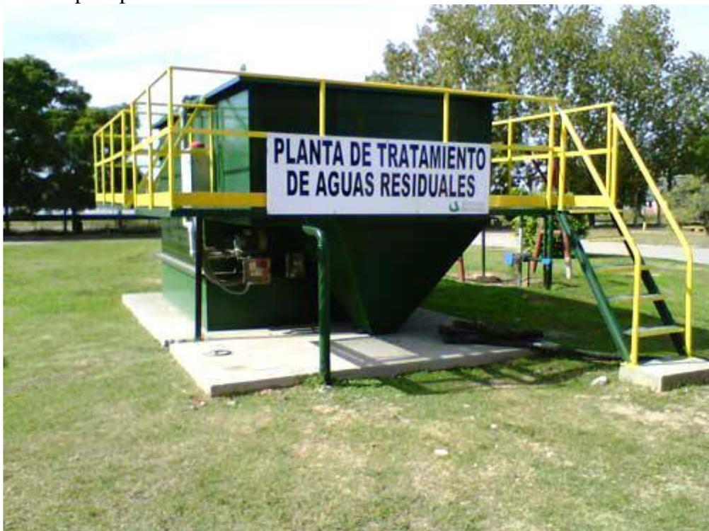
*Ilustración 147: Plantas Depuradoras Compactas de SPUR AMBIENTAL (SPUR)*
