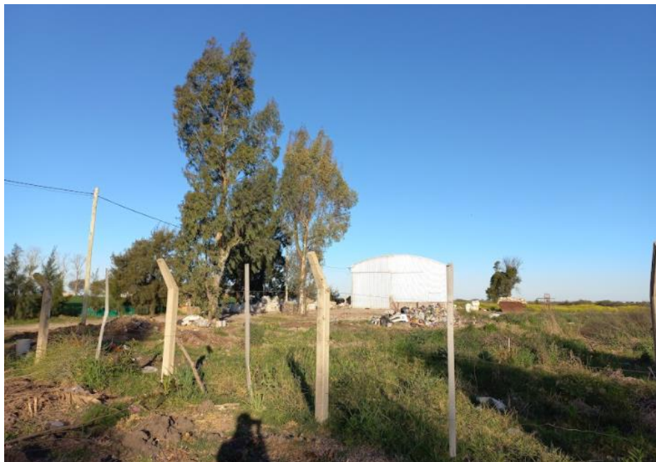
Figura N° 21 - Planta de tratamiento de residuos sólidos
