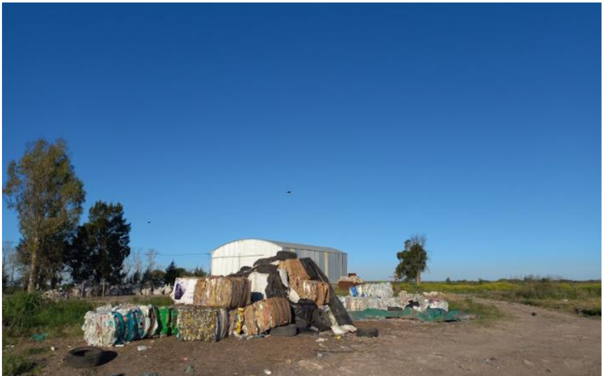
Figura N° 19 - Planta de tratamiento de residuos sólidos
