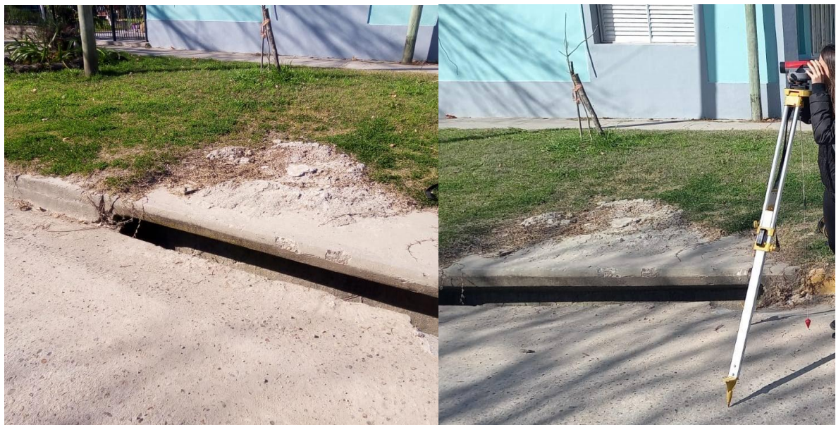
Imágenes N°67 y N°68 - Bocas de tormenta sobre la calle Mitre
