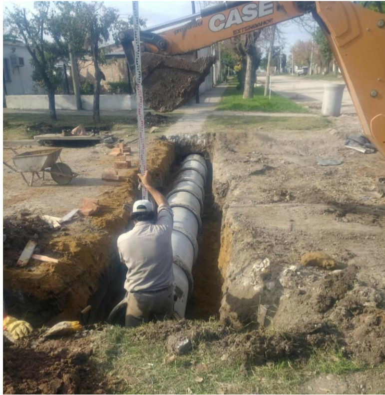
Figura N°65 - Conducto secundario sobre calle Uruguay
