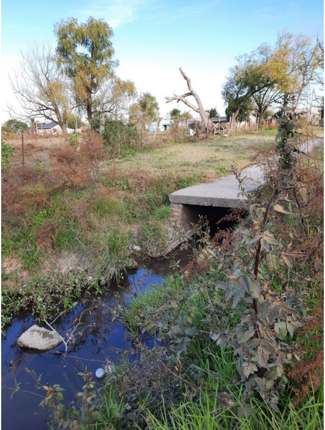
Figura N°66 - Conexión entre el colector principal existente en la calle Mitre y el desagüe natural
