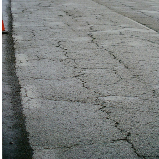
Figura 3.2. Fisuración por bloques por ciclos térmicos diarios. (Martínez et al., 2018)
