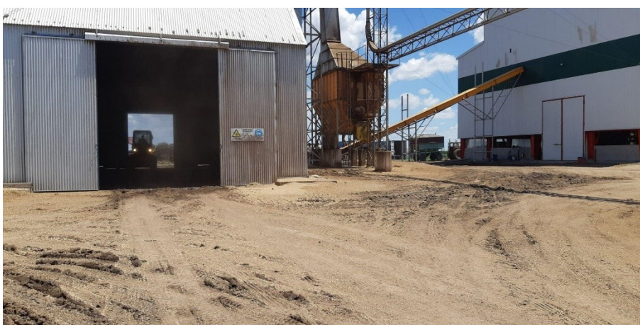
Figura N° 1.38: Vista general celda de descarga y tolva pulmón.
