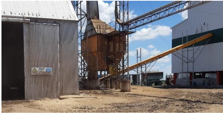
Figura N°1.6: Cinta transportadora de cascara de mani.
