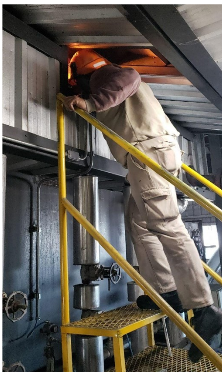
Figura N°1.42: Operario en inspección visual de fuego en caldera.
