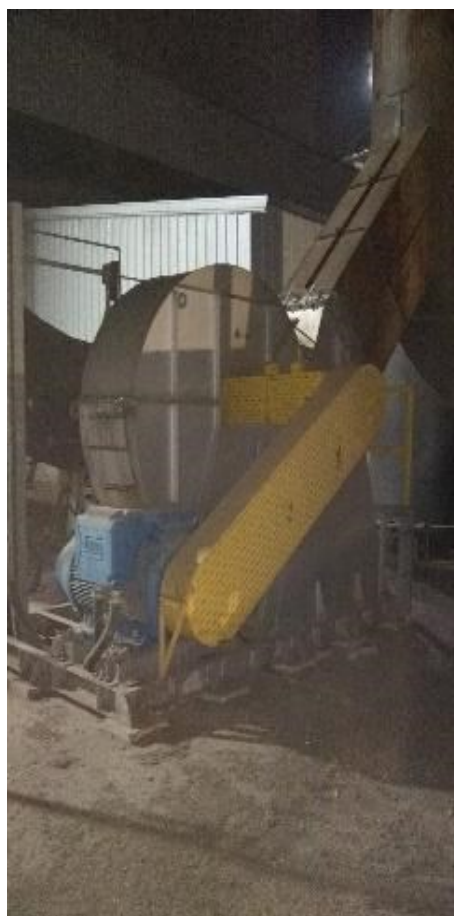
Figura N°1.12: Ventilador Tiro Forzado (VTI)
