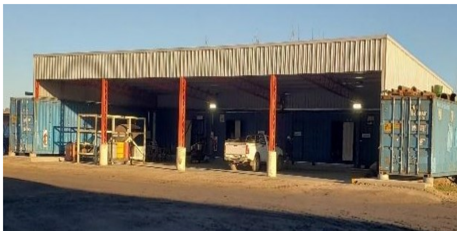
Figura N°1.23: Sector taller de Mantenimiento (Herramientas e insumos).
