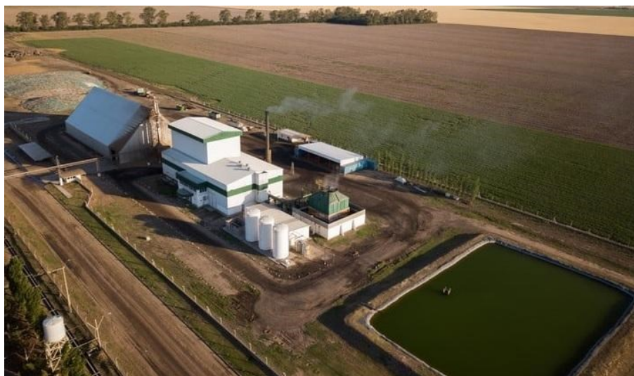
Figura N°1.1: Vista aérea Planta GTB.
