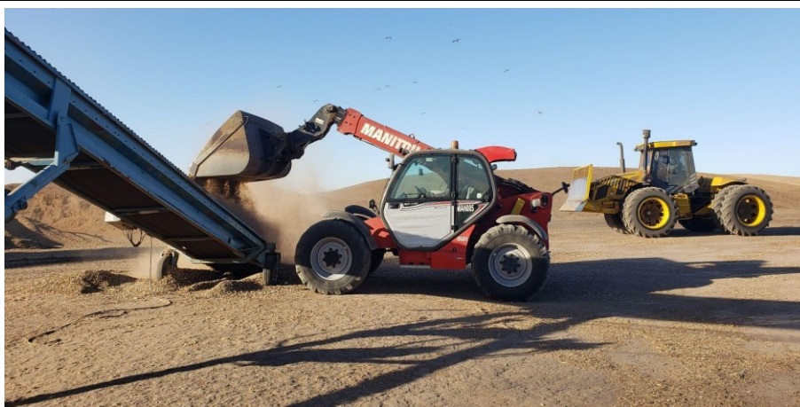
Figura N° 1.37: Operarios en tarea de pre limpieza y acopio/compactación.
