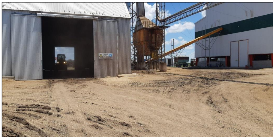
Figura N° 2.4: Vista general celda de descarga y tolva pulmón.
