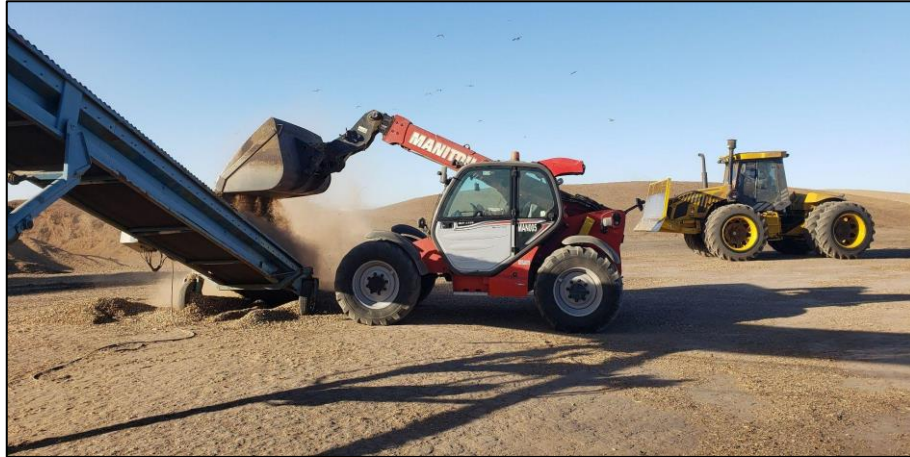
Figura N° 2.3: Operarios en tarea de pre limpieza y acopio/compactación.
