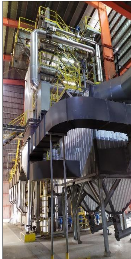
Figura N° 1.8: Caldera Acuotubular (22000 kgv/h x 45 bar x 120 °C).
