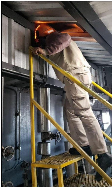
Figura N°2.8: Operario en inspección visual de fuego en caldera.
