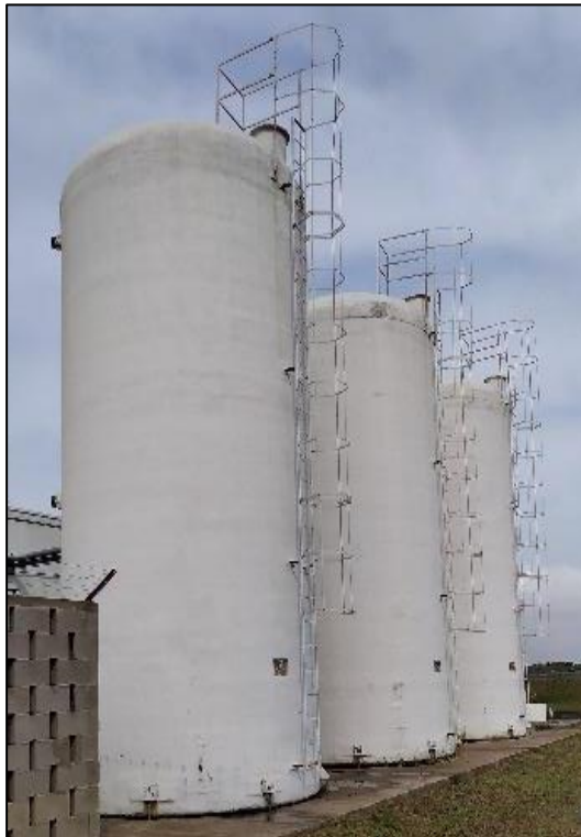
Figura N°1.23: Tanques de agua. Osmosis inversa.
