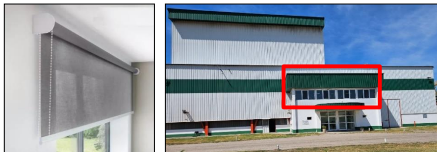
Figura N°3.31.: Modelo propuesto de cortinas roller sun screen 5% y vista externa ventanas de sala de comando.
