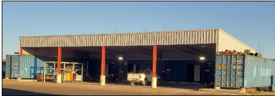
Figura N° 3.7.: Tinglado de sector taller de mantenimiento.
