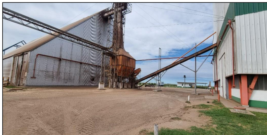
Figura N° 2.6: Vista de caño aéreo de ingreso por soplado hacia tolva pulmón.
