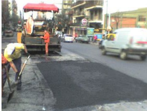
Figura 3.7. Zona reparada en la estructura del pavimento. (Fuente propia)
