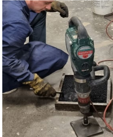
Figura 3.34. Compactación con percutor eléctrico de capa inferior. (Fuente propia)
