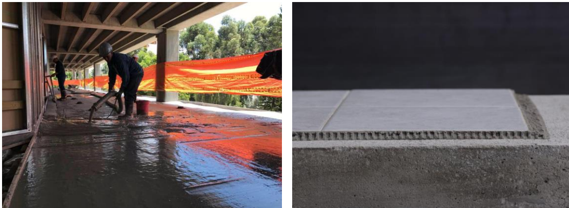
Fig. 5.1 – Aplicación y acabado final de hormigón celular
