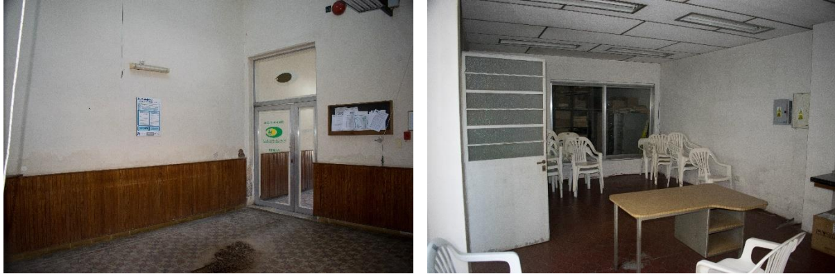
Fig. 2.3 – Interior de construcción existente
