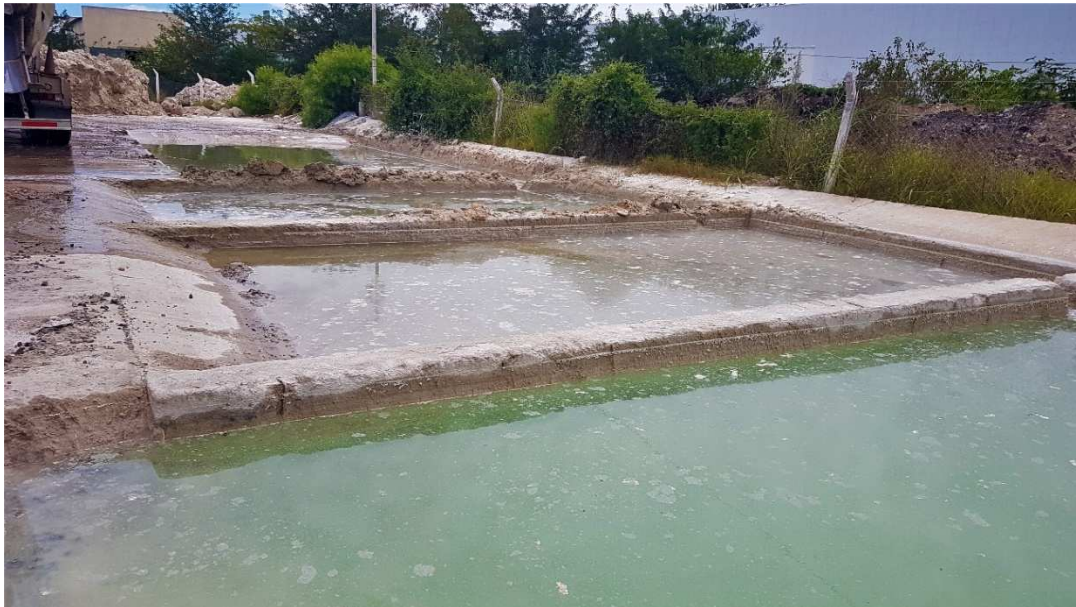
Imagen 9: Piletas de decantación del material proveniente del lavado de los camiones.
