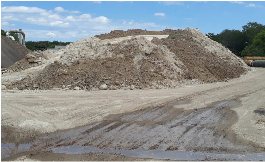
Imagen 10: Acopio del material sacado de las piletas de decantación
