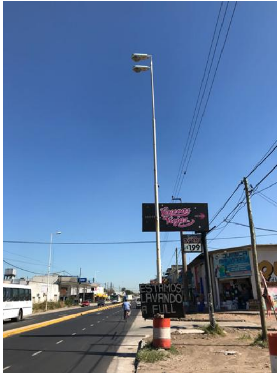
Figura 7: Postes en Ruta Nacional N°8, en el partido de Malvinas Argentinas. Fuente: Elaboración propia, Año 2018.
