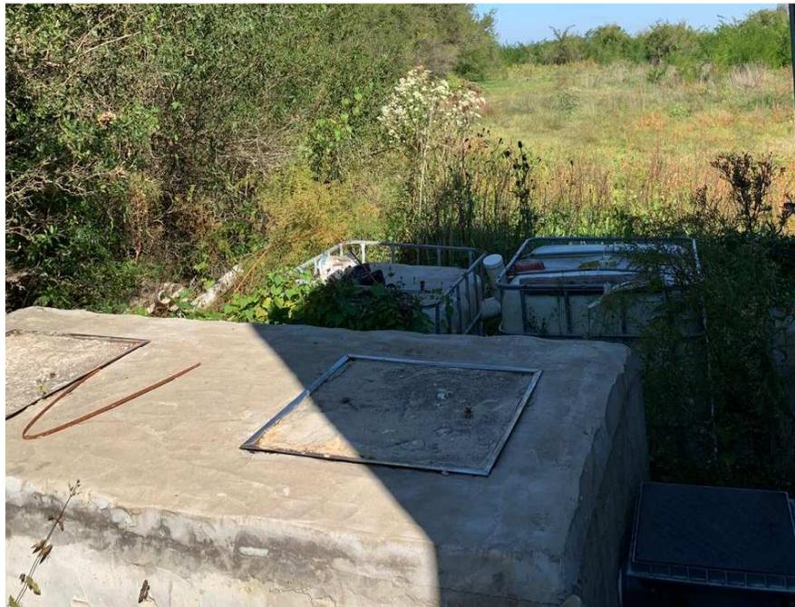
*Ilustración 22: Tanques para descarga de los efluentes al lecho de juncos. (Foto de alumnos, 2019)*
