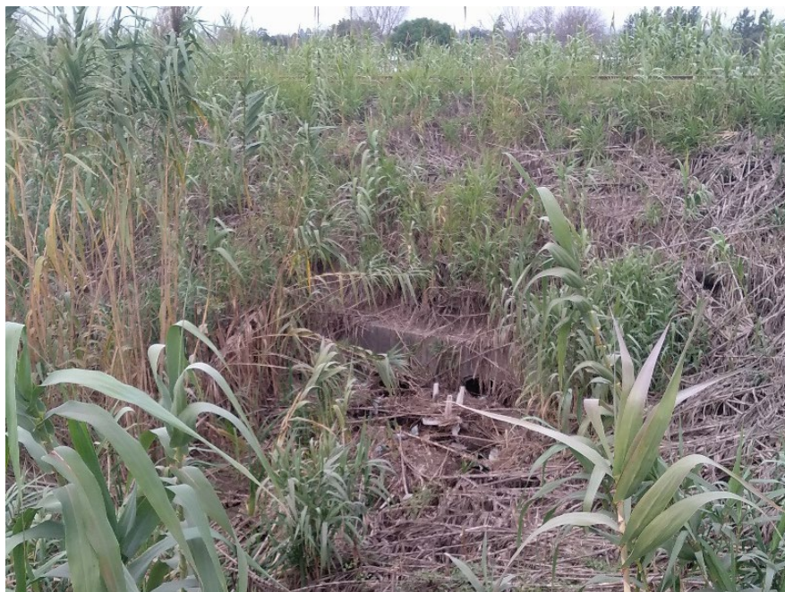
Fig. 5.2: Alcantarilla de las vías del FFCC (aguas arriba)
