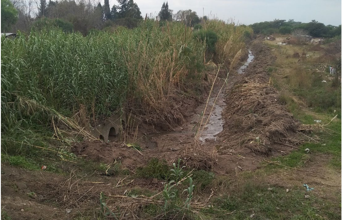
Fig. 5.3: Alcantarilla de las vías del FFCC (aguas abajo)
