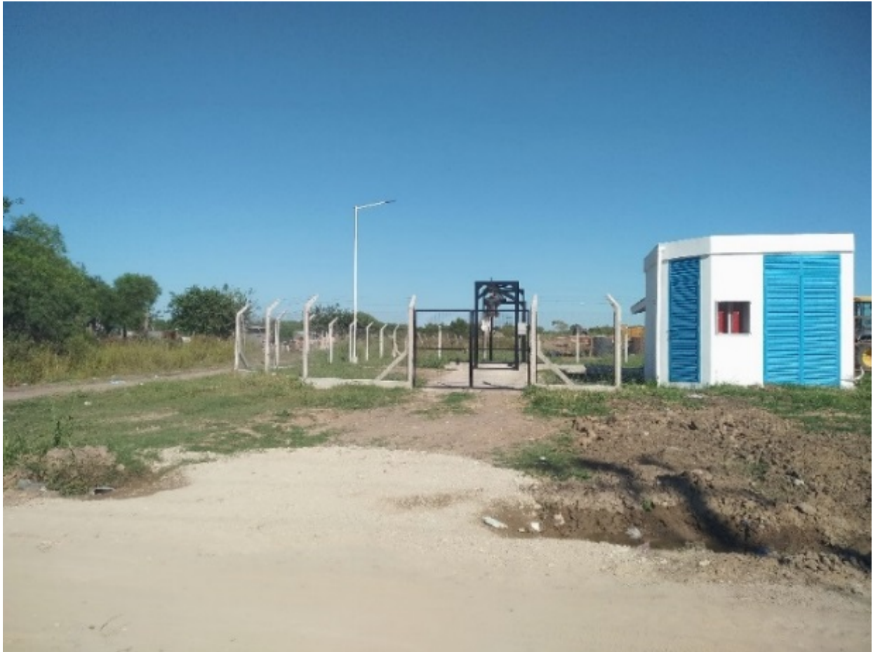
Fig. 1.5: Estación elevadora colector cloacal sureste
