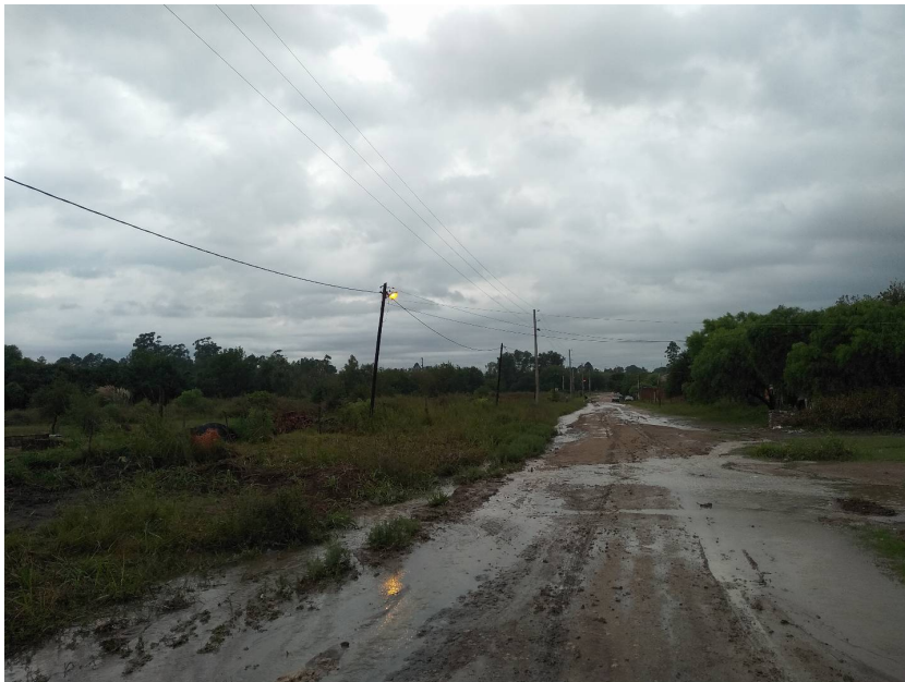
Fig. 1.7: Situación actual de la calzada en días de lluvia
