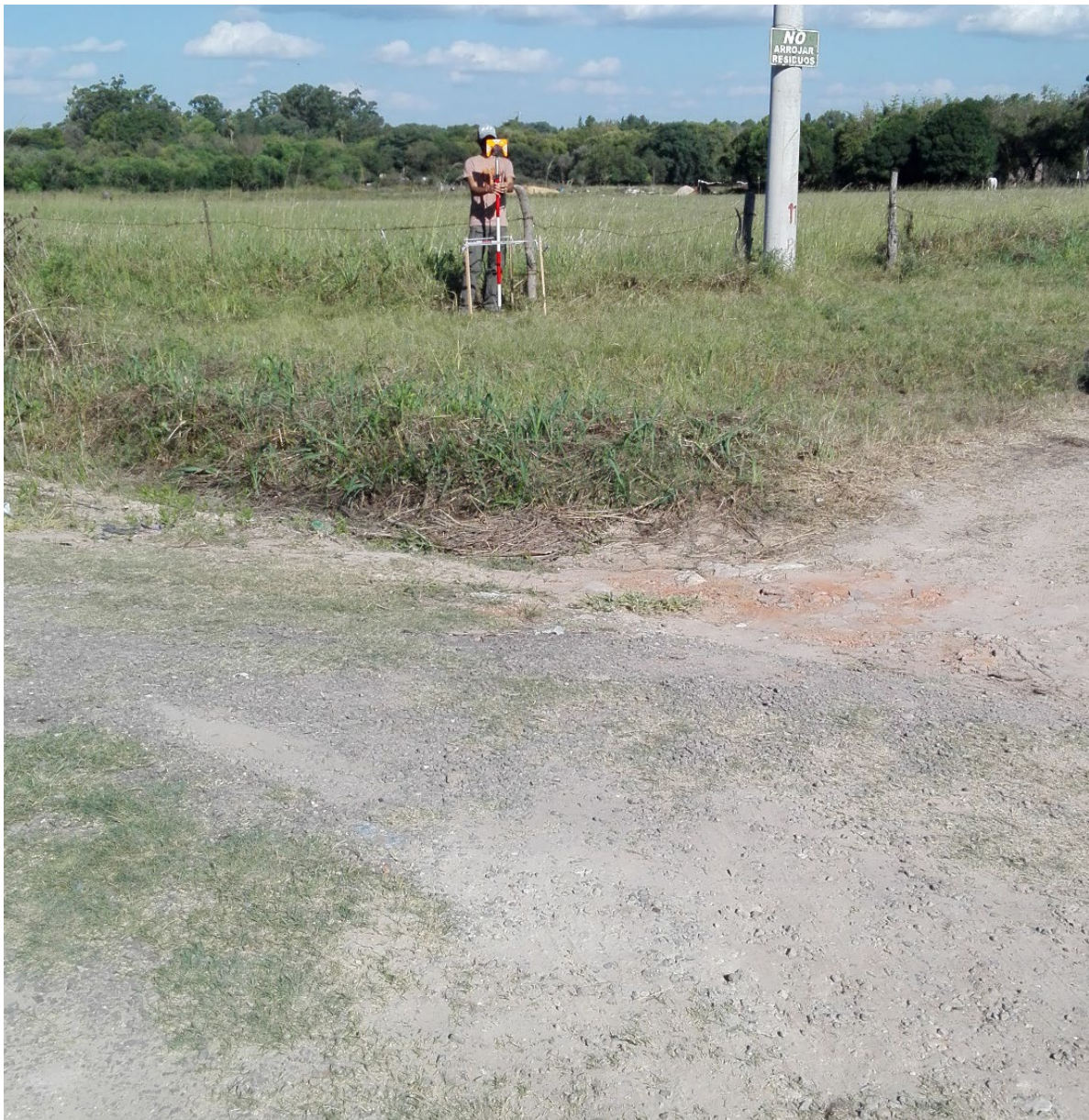
Fig. 3.3: Posicionamiento estación total con PP1
