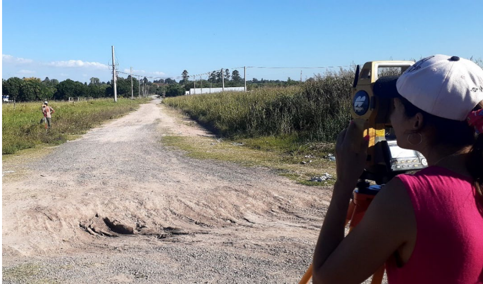
Fig. 3.4: Medición de puntos en las progresivas marcadas
