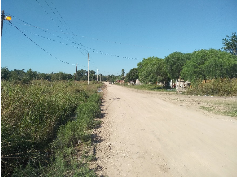
Fig. 1.6: Situación actual de la calzada
