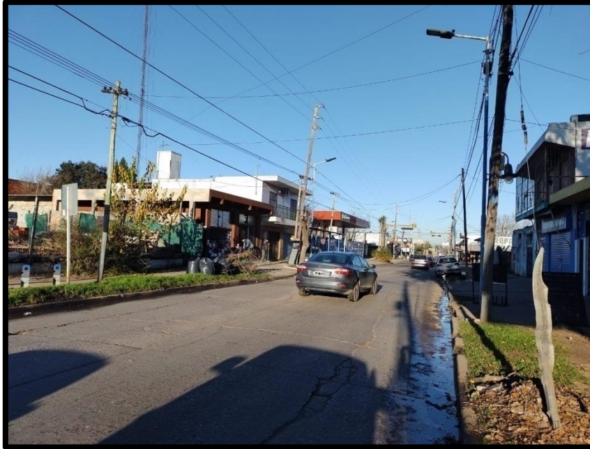
Figura 32. Estado de la AV. Fructuoso Diaz. Fuente elaboración propia.
