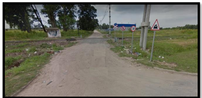
Figura 52. Paso nivel 04. No Regulado. Fuente elaboración propia.
