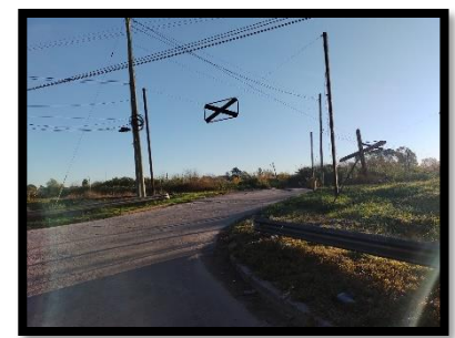
Figura 46. Paso nivel 03. No regulado. Fuente elaboración propia.
