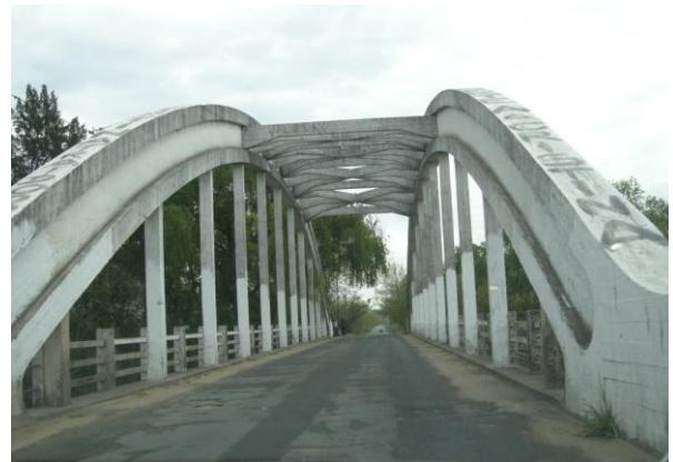
Puente de la Ruta Provincial Nº 25 sobre Río Luján
