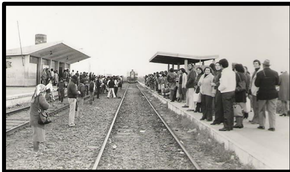
Figura 9. estación Maquinista Savio 1960. Extraído Google imágenes.
