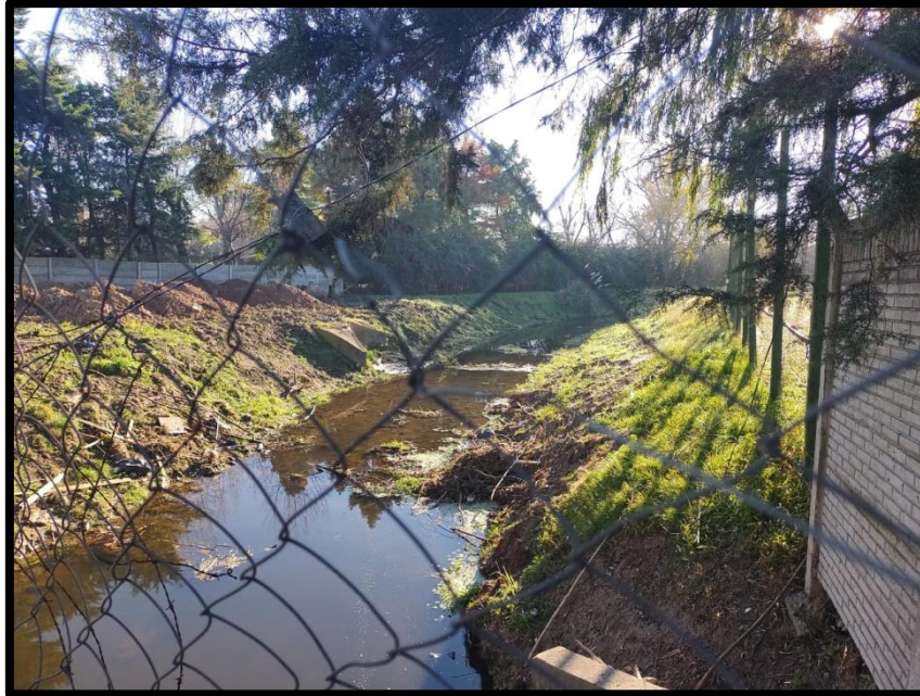
Figura 34. Arroyo Garín cruce con Patricias argentinas. Fuente elaboración propia.
