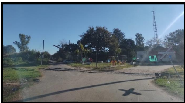
Figura 51. Paso nivel 08. No Regulado. Fuente elaboración propia.
