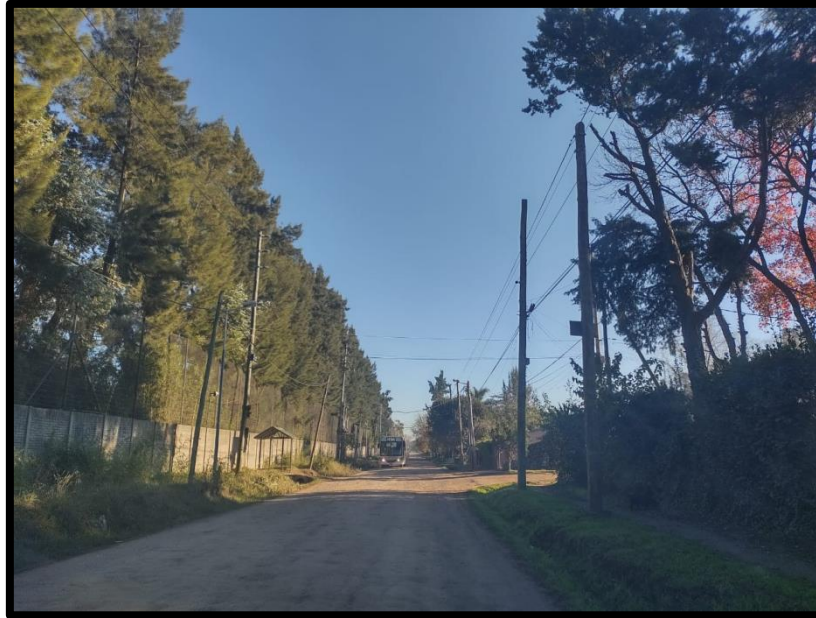
Figura 38. Estado de la calle Beliera. Fuente elaboración propia.
