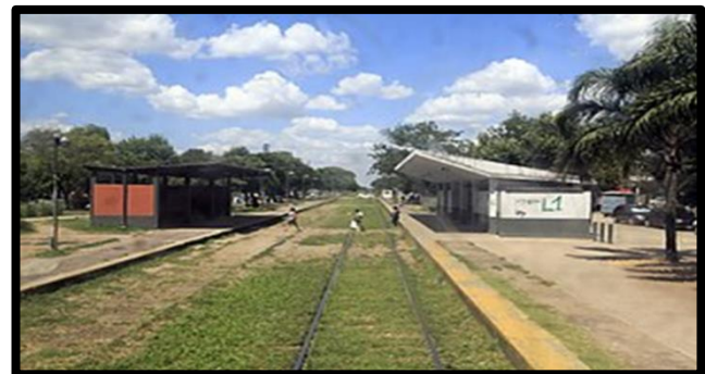
Figura 10. Estación Maquinista Savio 2020. Extraído de Google imágenes
