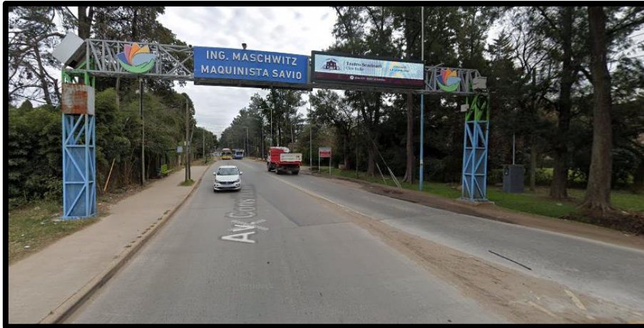
Figura 25. Ruta provincial N°26. Fuente Google maps.
