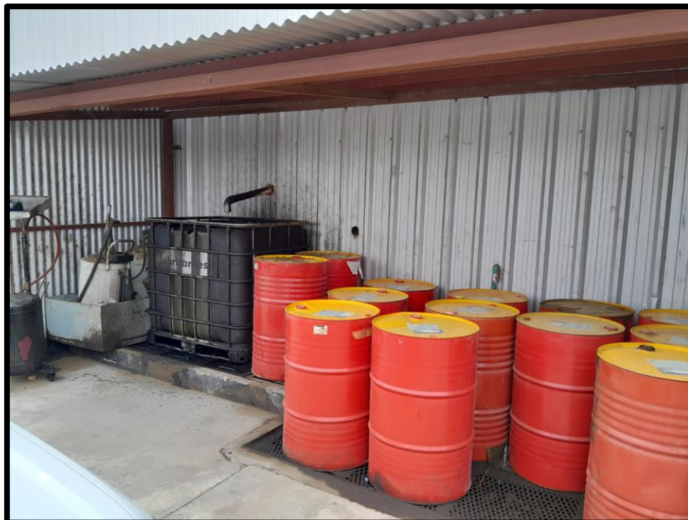
Anexo N°6: Depósito de tanques de aceite.
