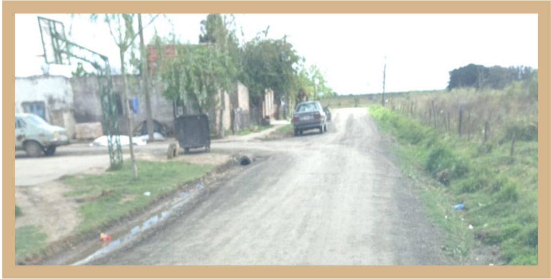
Figura 10: Calle con RAP en B° Malvinas Argentinas.
