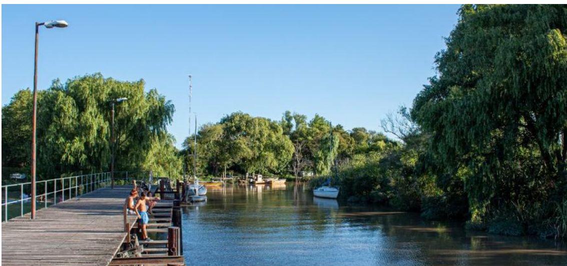
Imagen: Zona de esparcimiento (cuenta con luminarias).
