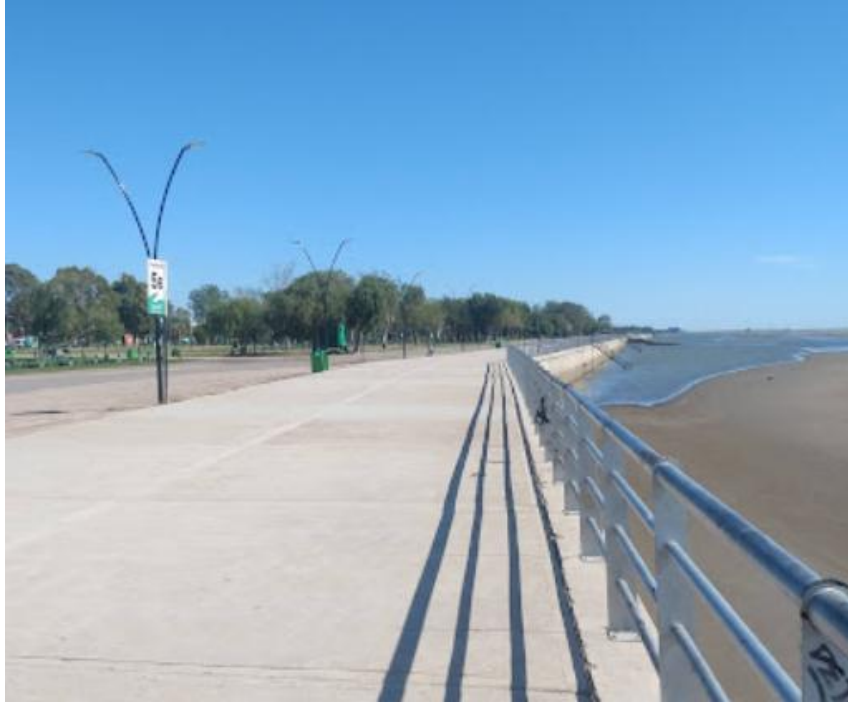
Imagen: Zona de esparcimiento (cuenta con luminarias).
