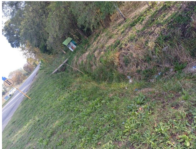
Imagen: Zanjón en rotonda de intersección entre Camino Sec. 065-04 y Av. Montevideo.
