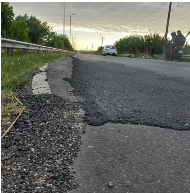
Figura 34. Bacheo realizado en la Av. Río de la Plata. Fuente: elaboración propia.
