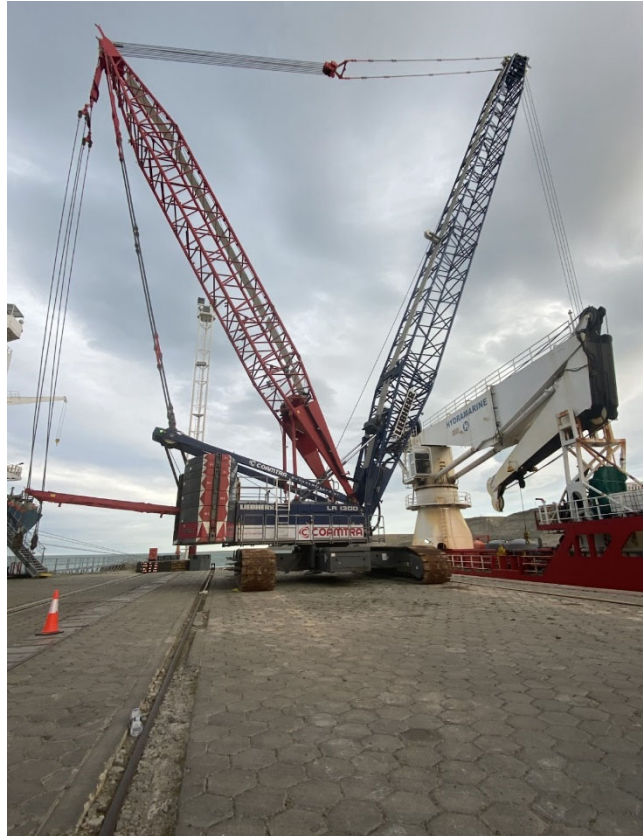
Fuente N°9: Toma fotográfica grúa Liebherr 300 Ton operando
