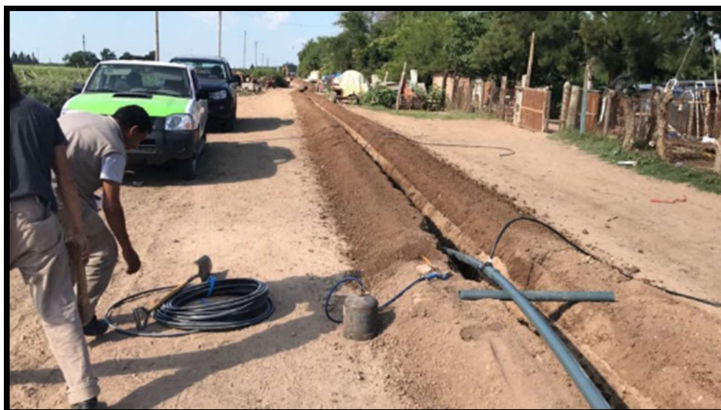
Imagen 21. Instalación de cañerías de red para agua potable – Fuente: canalwebsanpedro.com
