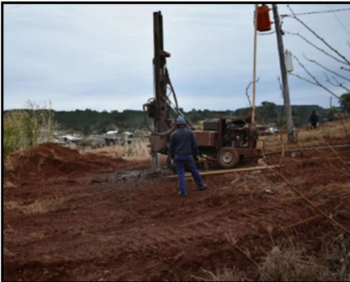
Imagen 24. Perforación para Nuevo Pozo de Agua – Fuente: El territorio, enero 2021
