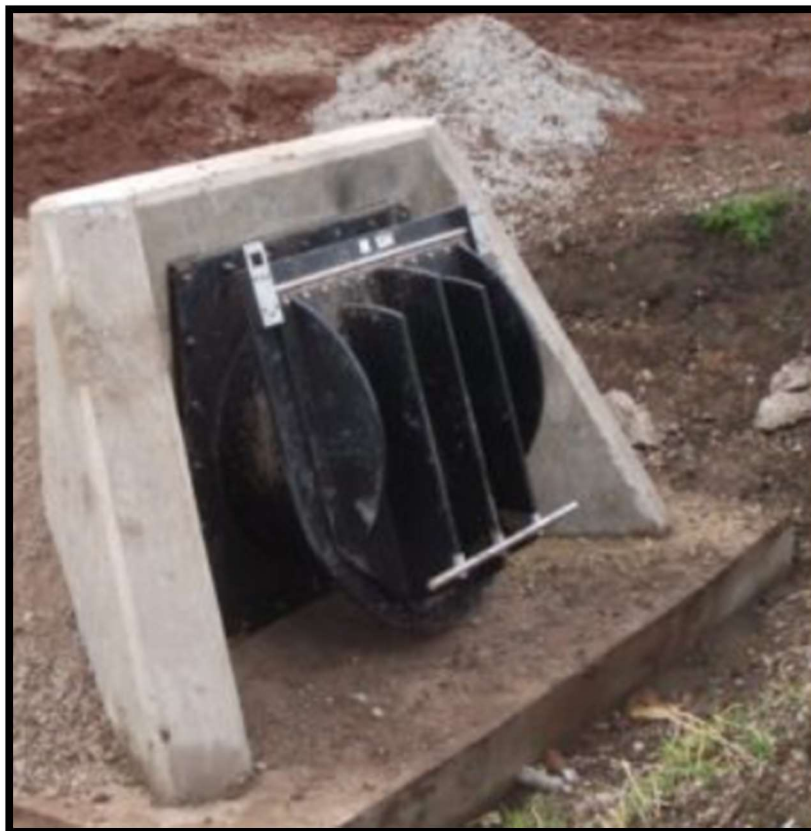
Imagen 101. Válvula anti-retorno – Fuente: accysa, año 2021
