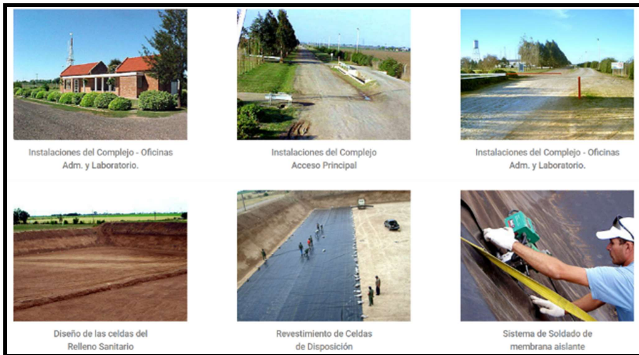
Imagen 60. Construcción de Relleno Sanitario San Nicolás - Fuente: Entre SRL
