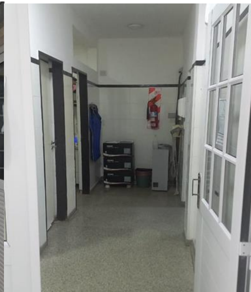
Imagen 5: Pasillo interno que conduce a la sala de Rayos X
