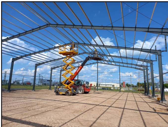
Figura 1.1: Estructura metálica. Obra Depósito CaCex - Parque Industrial Rafaela.
