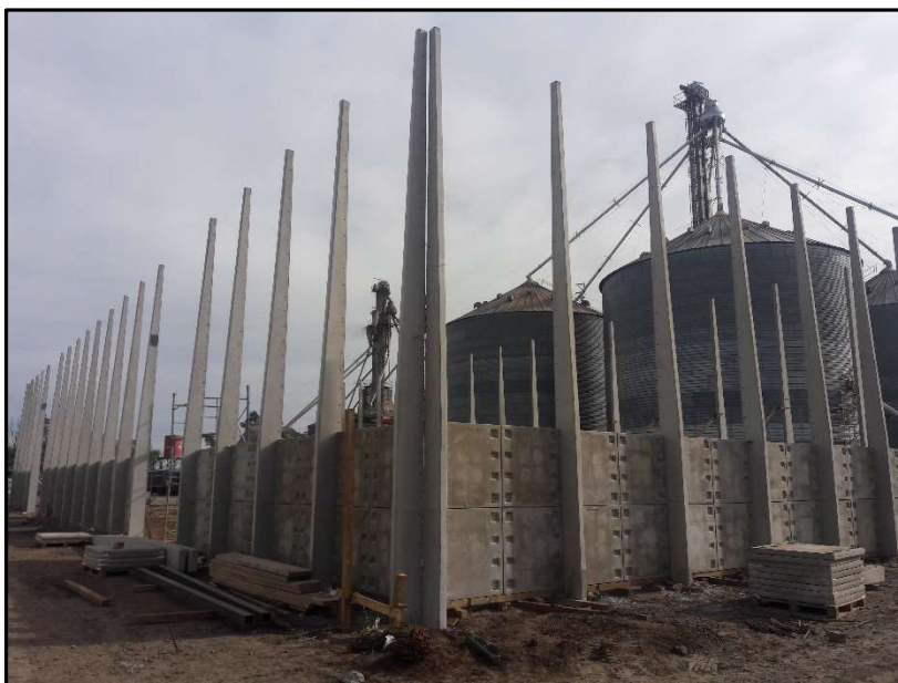
Figura 1.2: Estructura premoldeada de H º A º . Obra Coop. Gmo Lehman – Rafaela.
