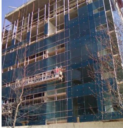
En obra deben ya estar colocados todos los anclajes, y en ellos se fijan los perfiles transversales y parantes, dejando lugar para la colocación del cristal. Todo esto respetando disposiciones a fin de evitar que el cristal encaje correctamente. Existen dos formas de fijar el panel de vidrio a la estructura, sea con contramarcos metálicos o pegado con cintas de doble contacto y silicona estructural.
