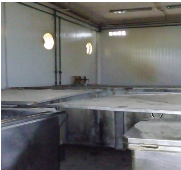
Figura 1.38. Rejillas de ventilación y extractores de aire del sector de cocina.
