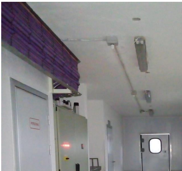
Figura 1.38. Bandejas pasa cable y luminaria principal
