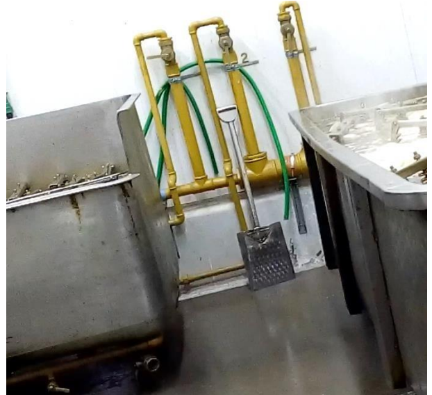
Figura 1.37. Cañería de ingreso de gas y llaves de paso individuales en la cocina.
