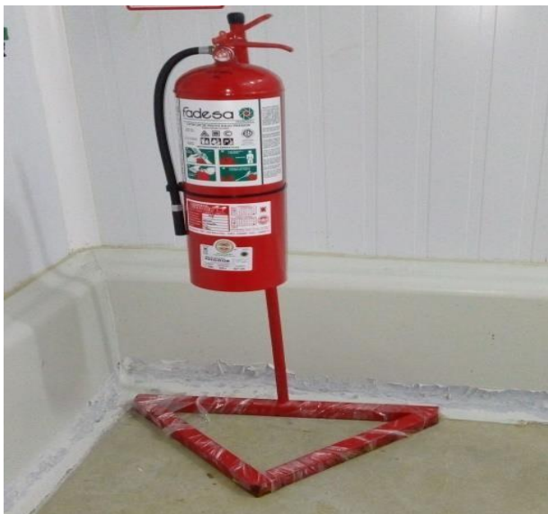
Figura 1.40. Matafuegos de polvo bajo presión ABC y salida de emergencia.
