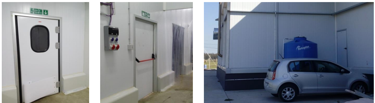
Figura 3.2. Salidas de emergencia del edificio.
