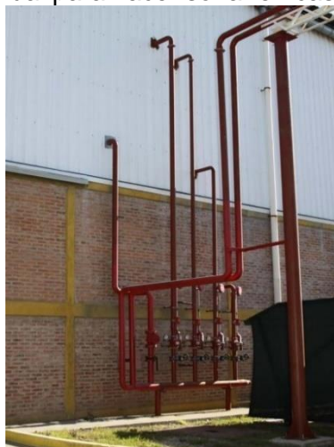
Figura 3.3. Ejemplo de algunos de los elementos que conforman la red contra incendio.
