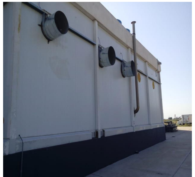
Figura 1.38. Rejillas de ventilación y extractores de aire del sector de cocina.
