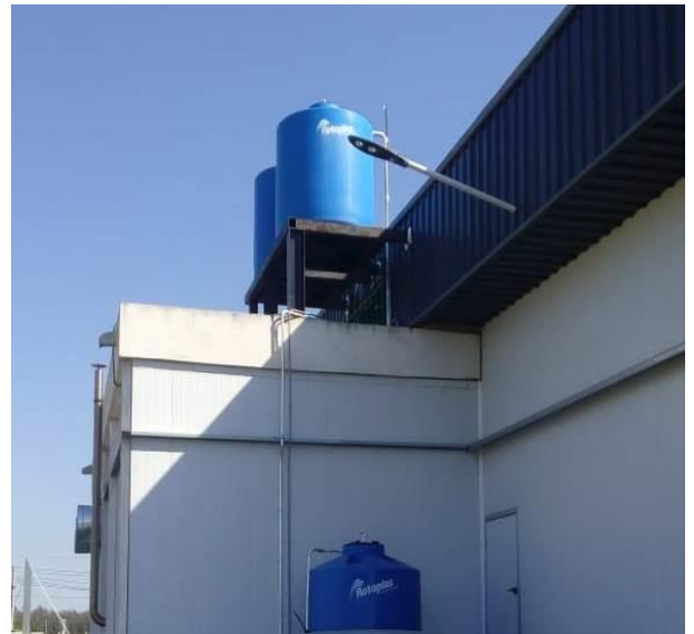
Figura 1.39. Tanque de bombeo y tanques de reserva de agua.
