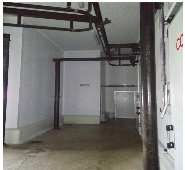
Figura 1.10. Portón marca Arneg con noria elevadora y espacio de antecámara sistema de rieleras.
