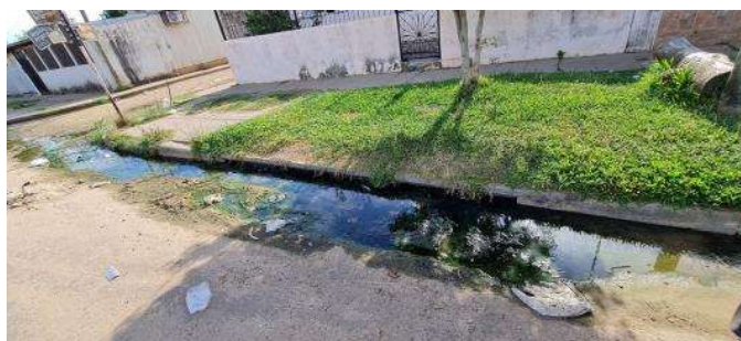
Figura N° 6: Agua en descomposición en calle Paula Albarracín de Sarmiento
