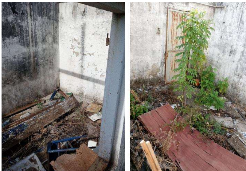
Figura N° 35 - Figura N° 36: Patio lindero a COPNAF
