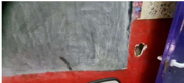
Figura N° 32: Detalle de paredes
