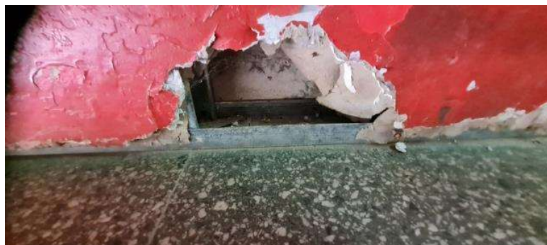
Figura N° 33: Detalle de paredes
