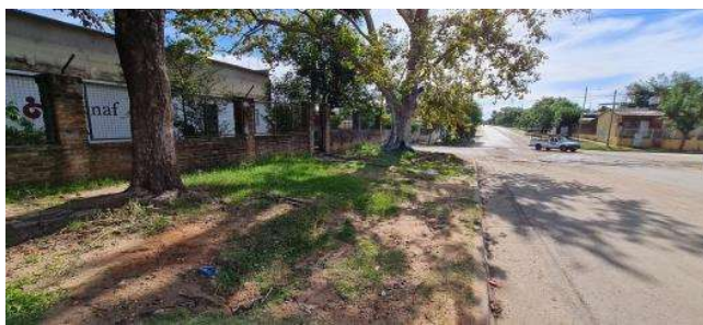
Figura N° 4: Vereda de Edificio COPNAF
