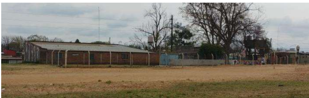
Figura N° 14: Escuela vista desde calle Isthilart
