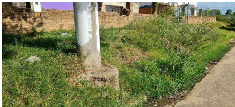
Figura N° 8: Vereda en calle Paula Albarracín de Sarmiento frente a Edificio COPNAF
