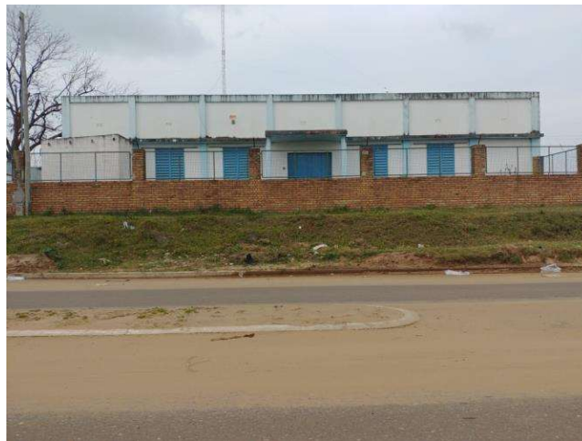
Figura N° 13: Escuela vista desde calle P.A. de Sarmiento
