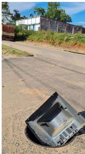
Figura N° 9: Tapa de TV reemplazando tapa de Boca de Registro en calle P.A. de Sarmiento
