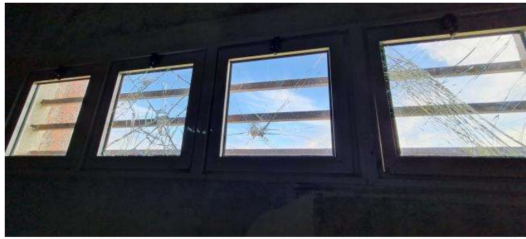
Figura N° 31: Detalle de aberturas
