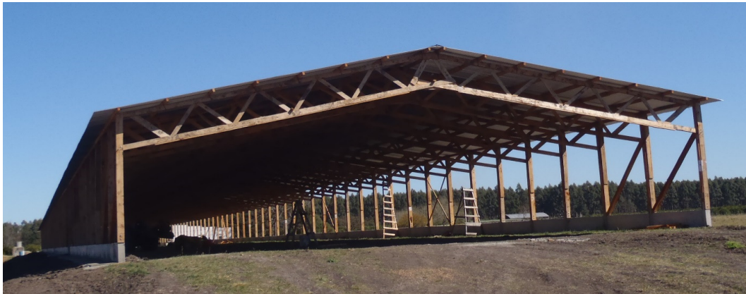
Figura 5. Estructura reticulada cuyas uniones se materializaron con clavos de pequeño diámetro
