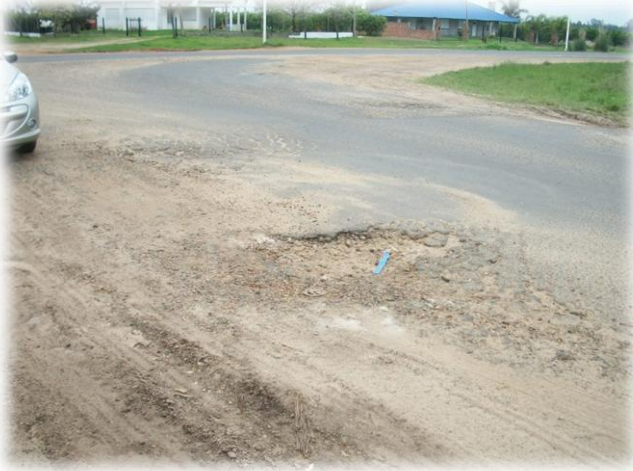
FOTO 01: Inicio de prog. 0+000. Intersección de Ruta "Tres Hermanas" y RP N°2.
