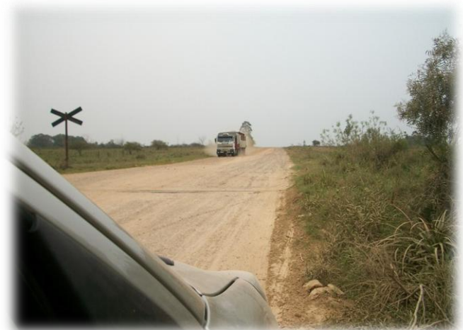
FOTO 04: Tramo sin pavimento entre porg. 1+400 / 2+100. Paso a nivel en prog. 1+770. Tipo de tráfico.
