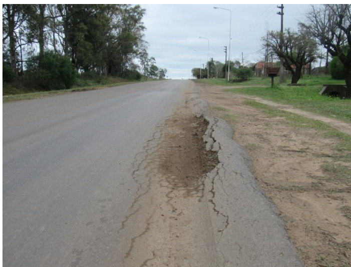
Imagen 6 – Ahuellamiento con deterioro avanzado sobre pavimento asfáltico existente.
