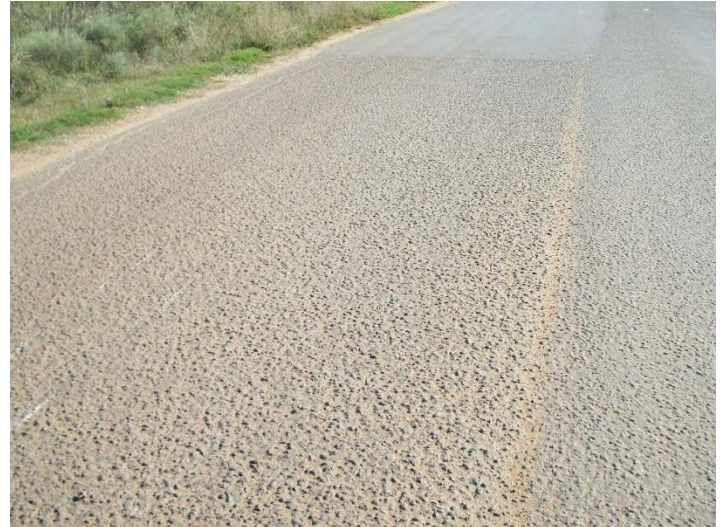
Imagen 11 - Cabezas duras sobre pavimento asfáltico existente.
