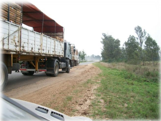
FOTO 05: Estado de banquetas y cunetas en tramo prog. 3+000 / 4+000. Tipo de tráfico.
