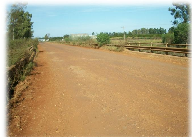
FOTO 06: Puente alcantarilla en prog. 4+090. Con protección flexible tipo gard rails.
