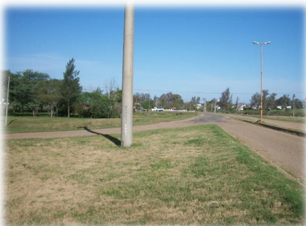
FOTO 11: Bifurcación en la prog. 6+200. Cunetas y alcantarillas de caños de hormigón con buen mantenimiento.
