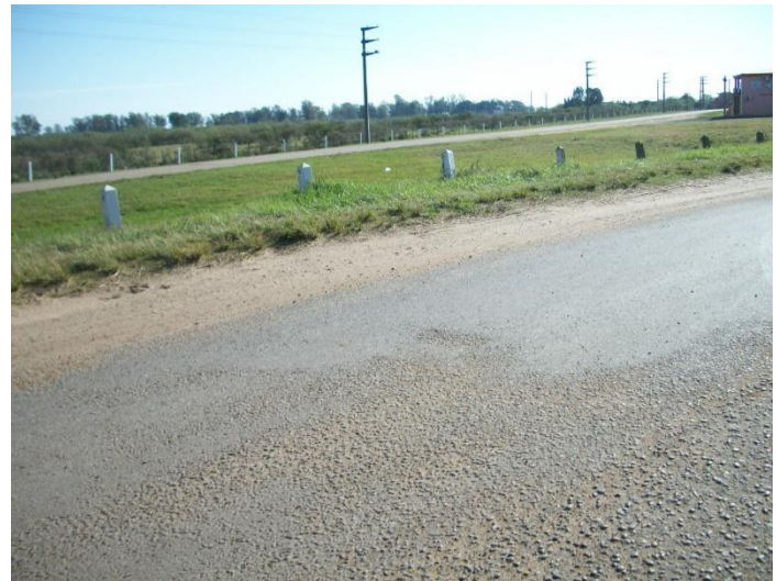
Imagen 9 – Pérdida de agregado sobre pavimento asfáltico existente.
