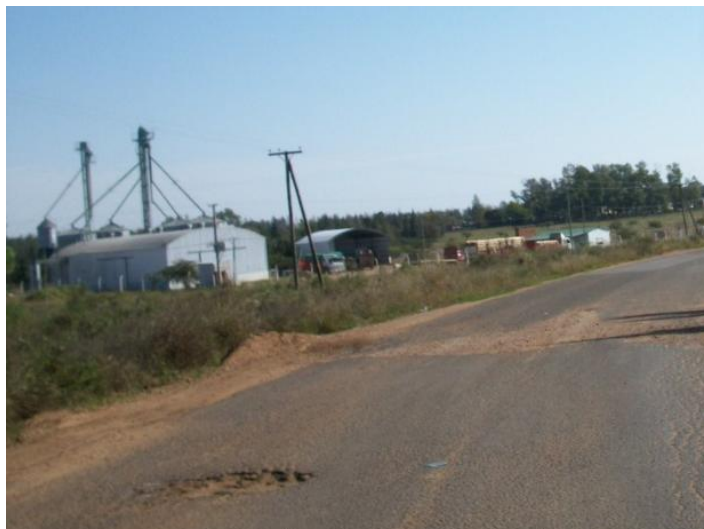
Imagen 7 – Baches sobre pavimento asfáltico existente.
