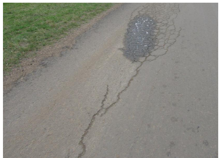
Imagen 1 - Fisura longitudinal sobre pavimento asfáltico existente
