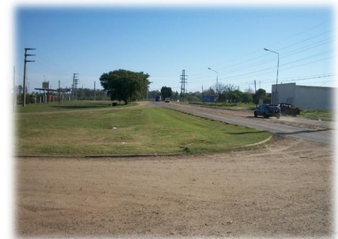
FOTO 12: Fin de prog. 6+290. Intersección de Ruta "Tres Hermanas" con Av. Dr. Casillas.
