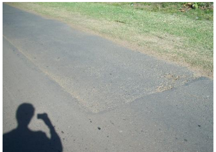
Imagen 8 – Parches sobre pavimento asfáltico existente.
