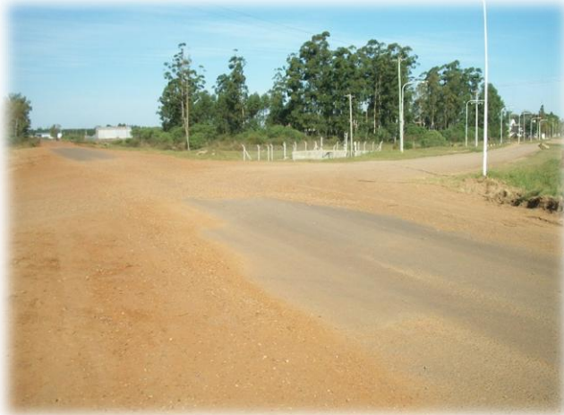
FOTO 07: Intersección en prog. 4+300 con Av. 28 de Mayo. Zona urbanizada B° Paso Chajarí.
