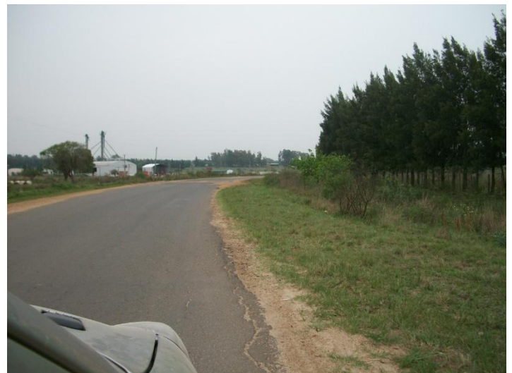
Imagen 3 - Fisuras de borde sobre pavimento asfáltico existente.
