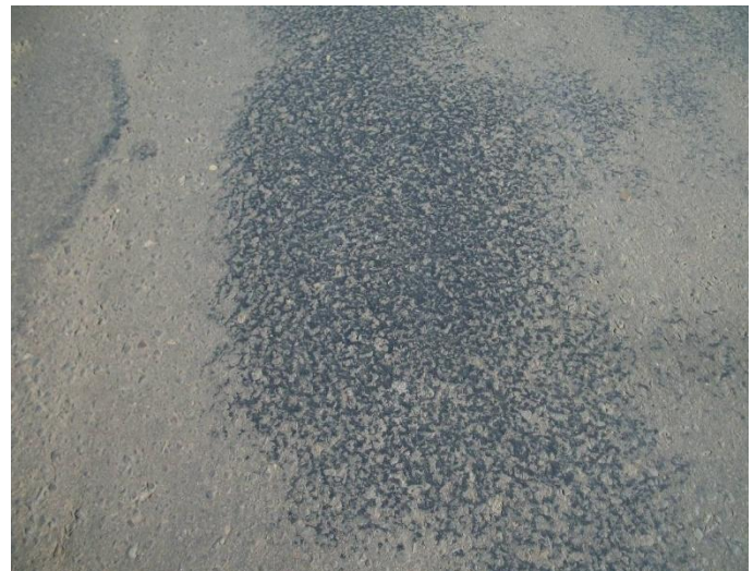
Imagen 12 - Exudación sobre pavimento asfáltico existente.
