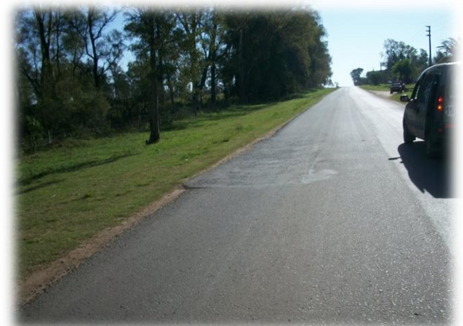
FOTO 10: Parches en el tramo prog. 5+000 / 6+290. Zona urbanizada B° Tacuabe y B° Militar. Tipo de tráfico.
