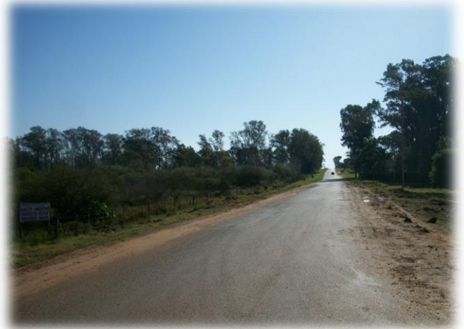
FOTO 08: Visible mejoramiento del perfil de la calzada a partir de la prog. 4+350. Zona urbanizada B° Paso Chajarí.
