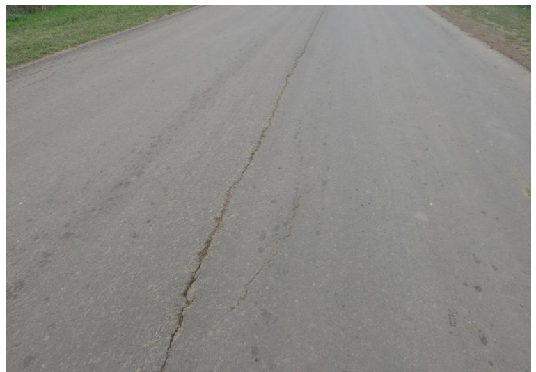
Imagen 2 - Fisura de construcción longitudinal sobre pavimento asfáltico existente
