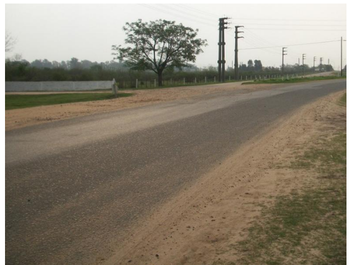
Imagen 10 – Desgaste superficial sobre pavimento asfáltico existente.
