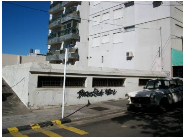
Foto 1 – Edificio y Playa de Cocheras
