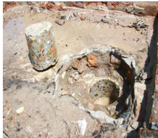
Foto 3 – Testigo extraído en losa
