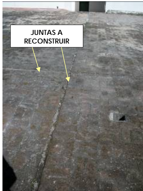
Foto 5 – Solado del estacionamiento superior
