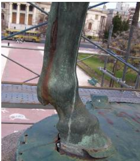
Fig. 2: Vista de la pata trasera del caballo. Se observa la fisura y las manchas de óxido causadas por la corrosión del hierro.
