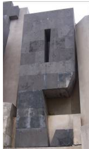
Fig. 11: Portal de Azul. Sigla RIP, en hormigón armado y revestida con placas de color negro, identificadas petrográficamente como dolomitas
