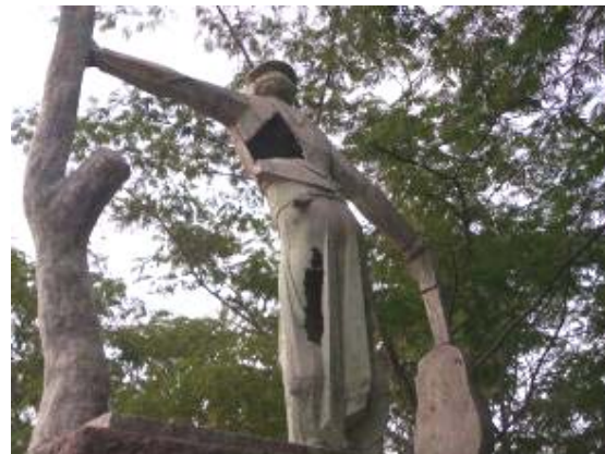
Fig. 17: Sectores dañados con pérdida de material, en el sector posterior.
