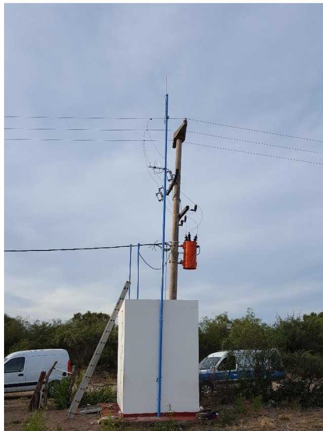
Fig. 10 Caseta de Control de Perforación
