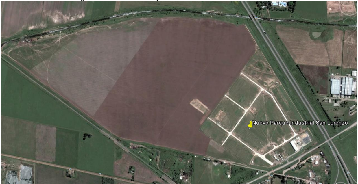
Fig.66 Vista Área Parque Industrial San Lorenzo
