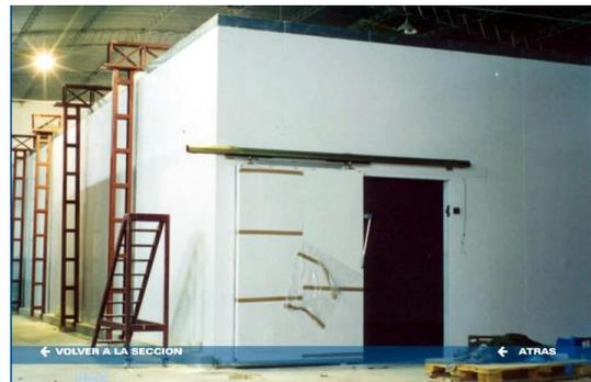
**2- Equipamiento frigorífico:** Compuesto por una unidad compacta monoblock de 2 HP de potencia, marca Bervill, totalmente automática, controlada por microprocesador digital incorporado.
