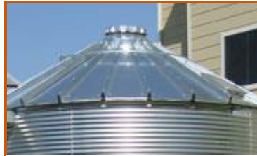
F 8.9 Techo de Silo.
