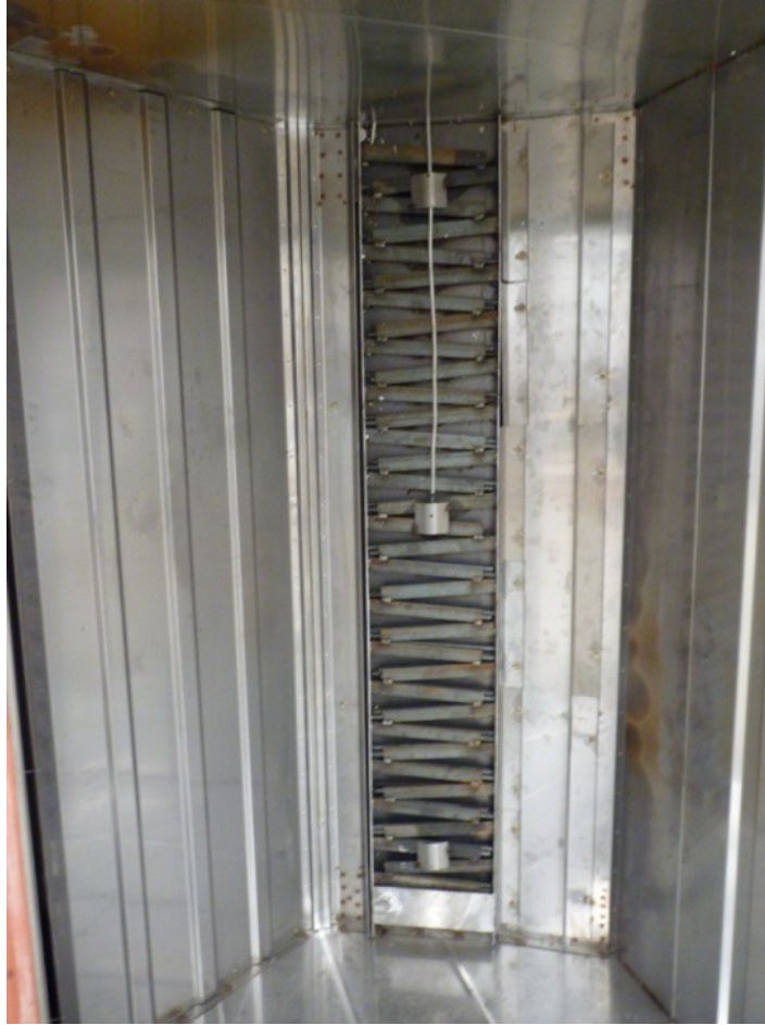
Fig. 11. Cascada de agua para vapor
