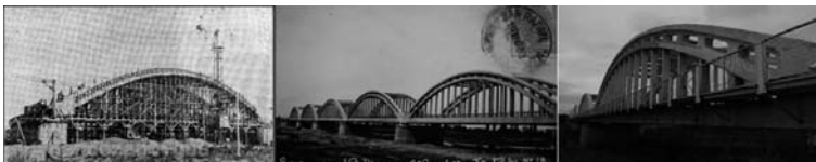
Fig.1 – Encofrado en etapa de construcción – Estado inicial de la estructura - Estado Actual de la estructura
