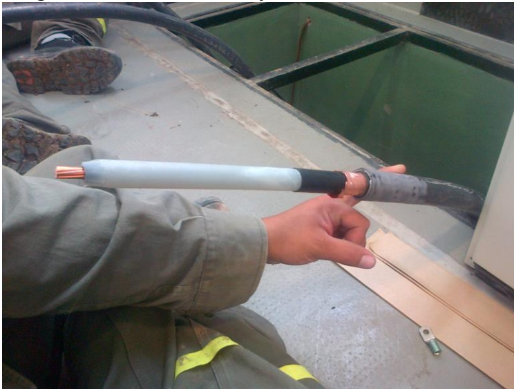
Imagen: Observe las diferentes capas del conductor de media tensión.
