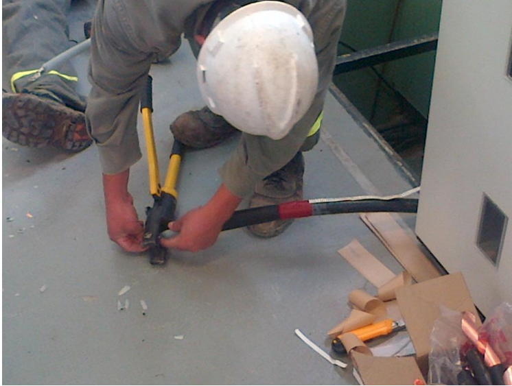
Imagen: Se colocan los terminales en las puntas.
