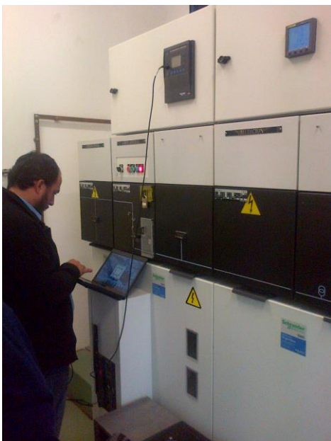
Imagen: Personal de SCHNEIDER regulando el interruptor principal.
