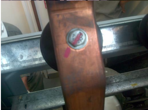
Imagen: Marca sobre las cabezas de los bulones.
