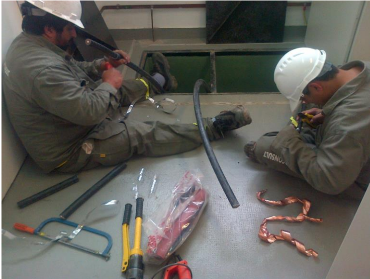
Imagen: Se comienza a trabajar sobre los conductores.
