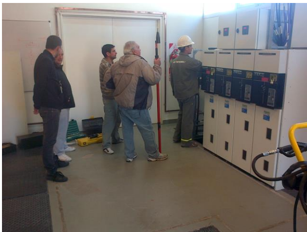
Imagen: Observe la pértiga que se utilizó en la maniobra.
