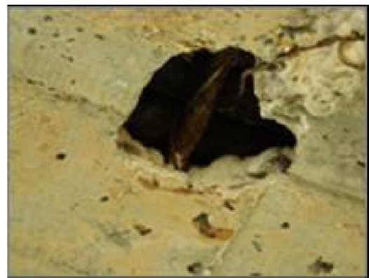
Fig 3- Vista de oquedades superficiales por deficiencia en el detalle o posicionamiento de la armadura y barras de acero dejadas como separadores (izq.). Oquedad en la cara inferior de una viga principal donde se ve el hierro expuesto al medio ambiente (der.)
