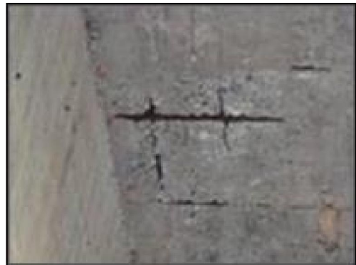
Fig 2- Armadura expuestas y con procesos corrosivos en viga sobre estribos (izq.). Y en parte inferior de losa de tablero (der.).
