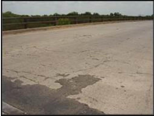
Fig 1- Losa de puente afectada por reacción álcali-agregado (izq.). Vista de la lixiviación, en la cara inferior del tablero del puente (der.).
