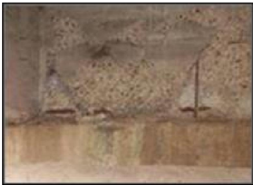
Fig 2- Armadura expuestas y con procesos corrosivos en viga sobre estribos (izq.). Y en parte inferior de losa de tablero (der.).
