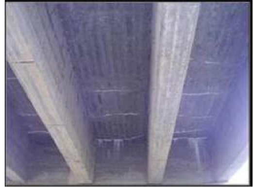
Fig 1- Losa de puente afectada por reacción álcali-agregado (izq.). Vista de la lixiviación, en la cara inferior del tablero del puente (der.).
